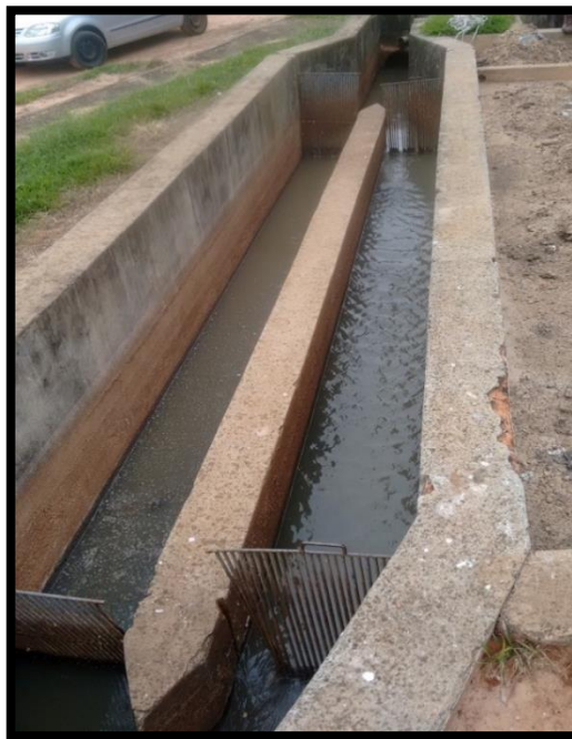
Figura 9- Esgoto bruto (P6) na caixa de areia da Estação de Tratamento de Esgoto de Dracena - SP, 2017
