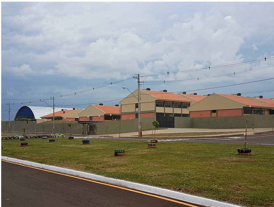
Foto 5: Fachada do colégio estadual. Fonte: Danilo Alcantara, novembro de 2017.
