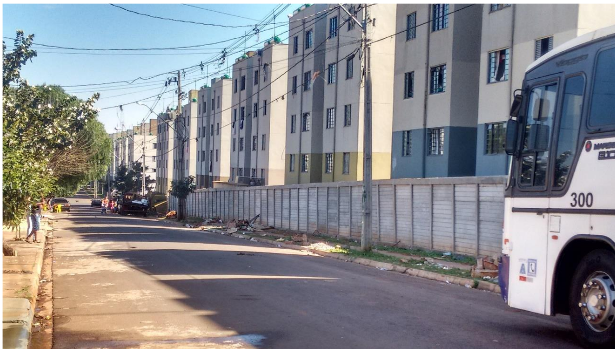
Foto 4: Muro de concreto em processo de construção. Fonte: Danilo Alcantara, julho de 2017.
