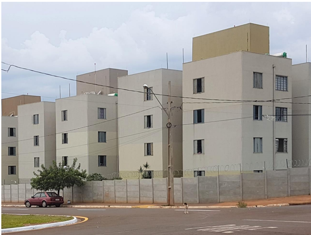
Foto 7: Condomínio de apartamentos no qual a cerca de arame foi substituída por muro de concreto com aparato de segurança. Fonte: Danilo Alcantara, novembro de 2017.
