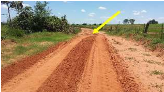
Passagem de tubo de concreto 2.
