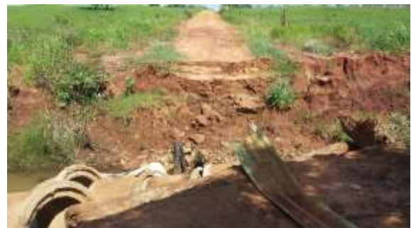
Trecho interditado: ponte caída sobre o Córrego do Apiaí, km 7,2.
