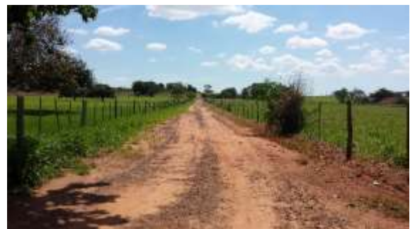
Revestimento primário com pedra brita.
