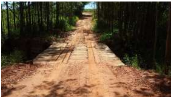
Ponte de madeira sobre o Córrego da Capivara.
