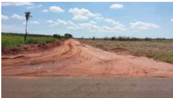
Início: Estrada OVD – 040, km 7,39.
