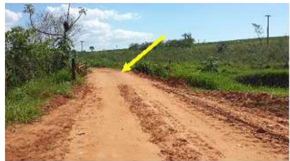
Ponte de concreto sobre o Córrego do São Bento, km 1,7.
