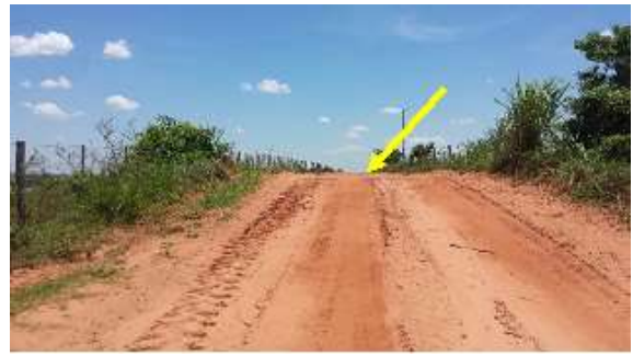
Passagem de tubo de concreto 1.
