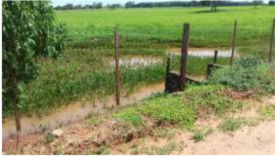
Detalhe da tubulação de concreto.
