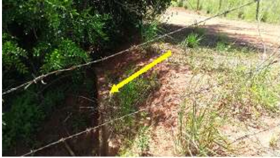
Passagem com tubo.
