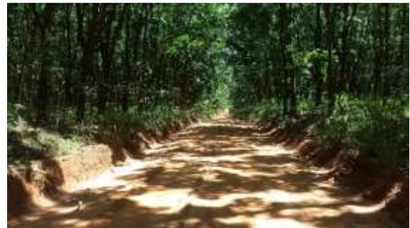
Trecho encaixado: barranco entre 2,0 e 3,0 m de altura.
