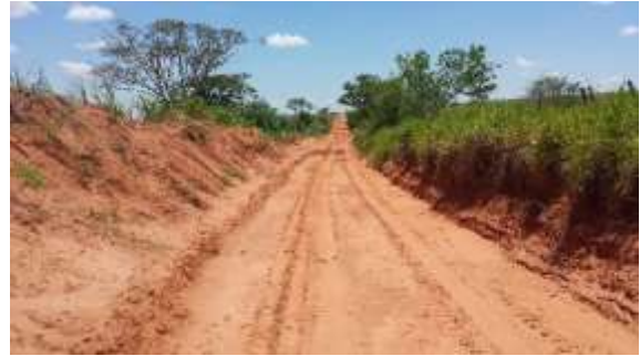
Trecho encaixado: barranco entre 1,0 e 1,5 m de altura.
