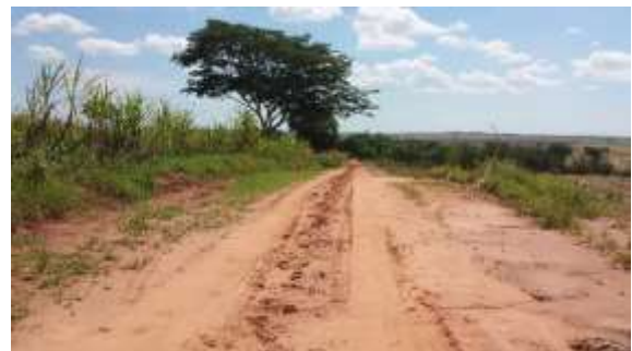
Escoamento superficial das águas pluviais.
