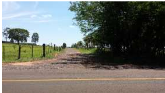
Início: Estrada OVD – 040, km 2,13.
