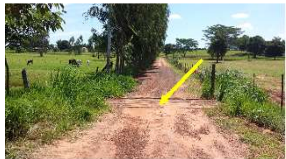
Tubulação de concreto, com tablado de madeira.
