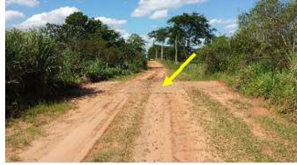
Passagem de concreto 1.
