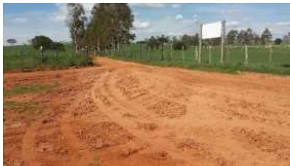
Início: Estrada OVD 360, km 2,45.
