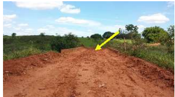
Ponte de concreto sobre o Córrego Vista Alegre.
