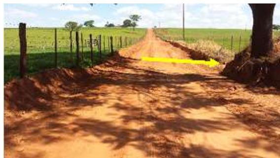
Passagem de águas pluviais, km 1,5.
