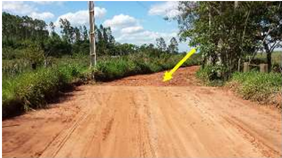
Passagem de concreto 2.
