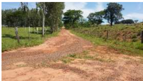
Trecho lateral 02 – 475 m.
