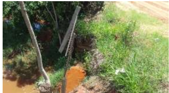
Detalhe: passagem de tubo de concreto.
