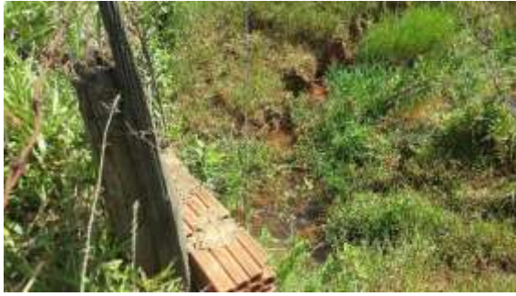
Passagem de água com tubo de concreto, km 2,15.
