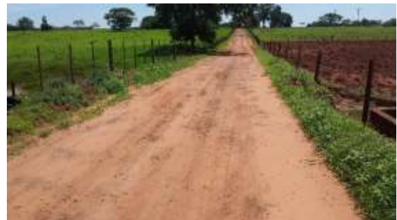
Tubulação de concreto para passagem de água.
