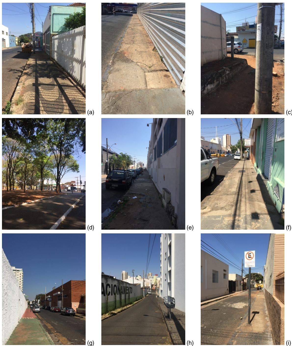
Figura 15 - Problemas encontrados nas calçadas na área de avaliação. (a) 906D – tipo de piso; (b) 806D - irregularidades na calçada; (c) 908D - ausência de calçada; (d) 708B - tipo de piso; (e) 408D - irregularidades na calçada; (f) 413C - irregularidades na calçada; (g) 208A - fachadas completamente fechadas e ausência de árvores; (h) 109C - largura das calçadas, ausência de árvores e fachadas totalmente fechadas; (i) 505C - largura das calçadas, tipo de piso, ausência de árvores.
