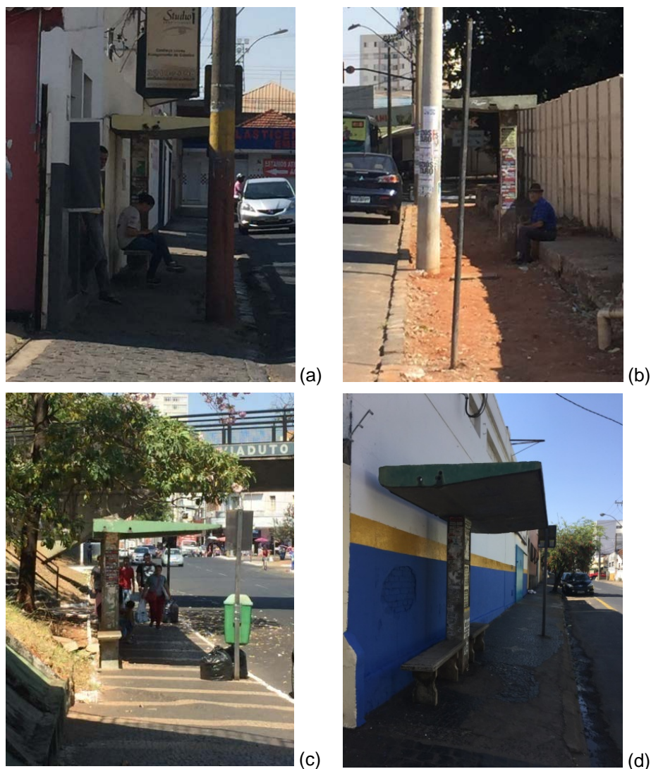
Figura 21 - Pontos de ônibus localizados na área de avaliação. (a) 906D; (b) 908D; (c) 404A; (d) 313D - todos os pontos instalados dentro da faixa de circulação da calçada, com ausência de espaço de espera para cadeirantes e painel de informações.
