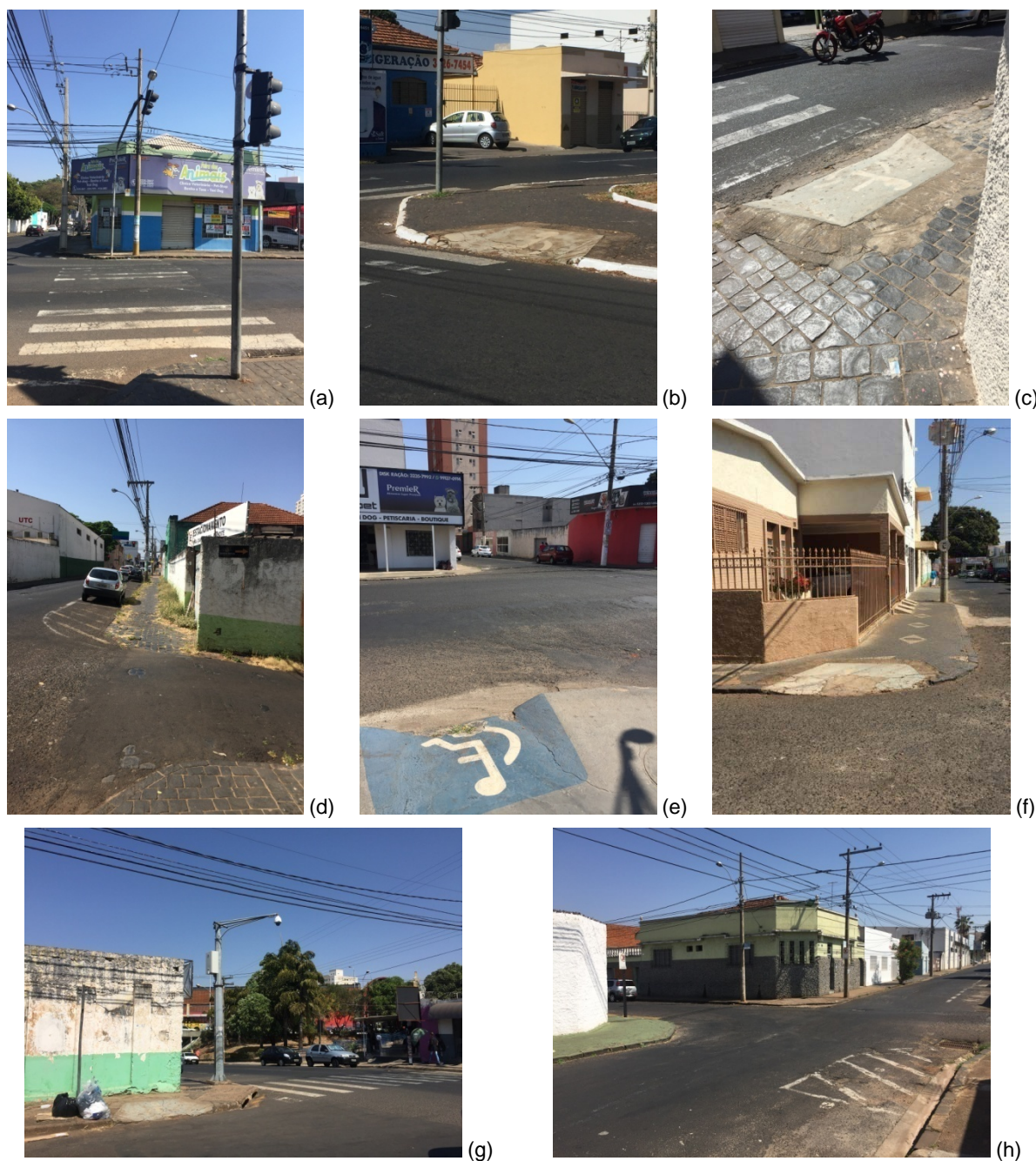
Figura 19 - Problemas encontrados nas intersecções na área de avaliação. (a) 906D – faixa de pedestre descolorida; (b) 708C - estado de manutenção do rebaixo de calçada; (c) 308C - ausência de faixa de circulação após rebaixo de calçada; (d) 108B condição das calçadas e ausência de rebaixos de calçada; (e) 706B - estado de manutenção do rebaixo de calçada e ausência de faixa de pedestre; (f) 504B - ausência de faixa de circulação após rebaixo de calçada, ausência de faixa de pedestre; (g) 505A - ausência de faixa de circulação após rebaixo de calçada e ausência de faixa de pedestre; (h) 208B - ausência de rebaixo de calçada e faixa de pedestre.
