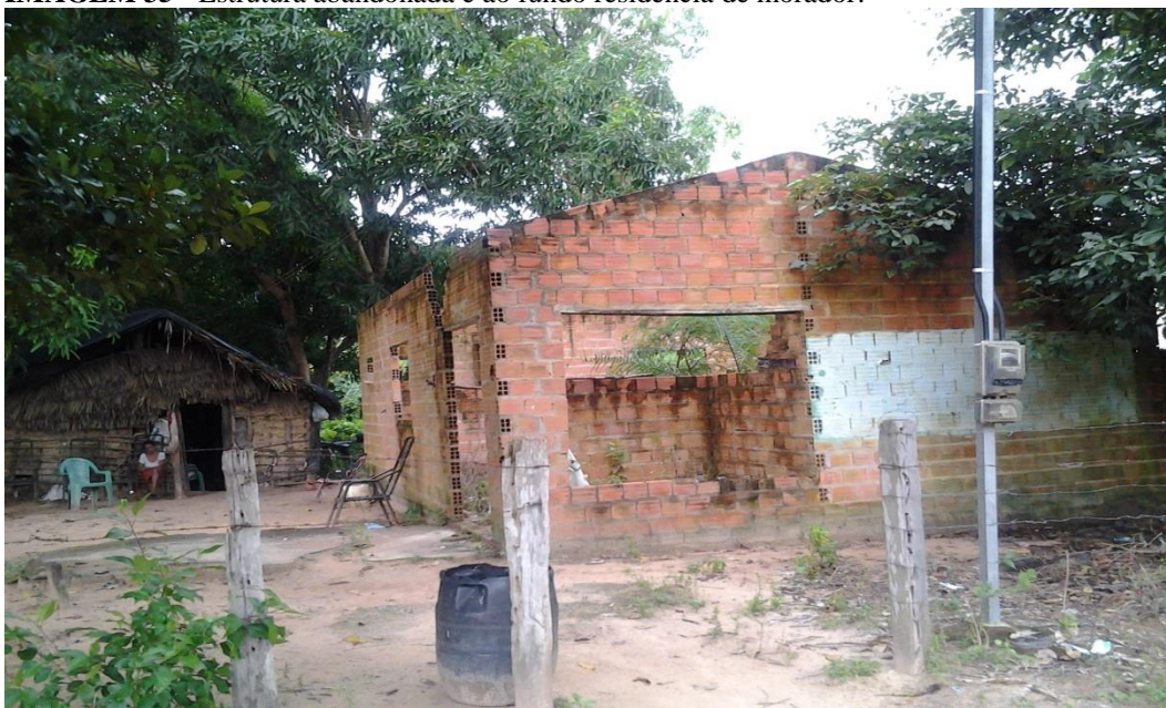
IMAGEM 35 - Estrutura abandonada e ao fundo residência de morador.
