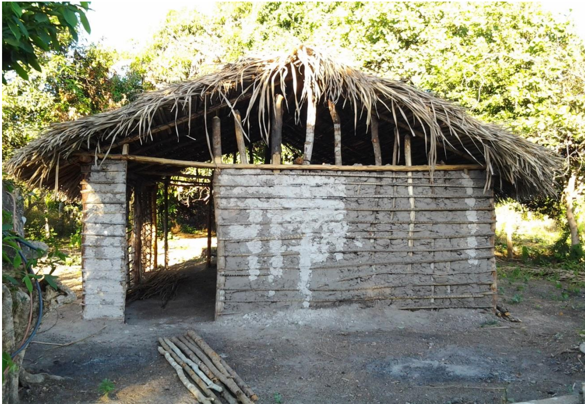
IMAGEM 20 - Casa em construção, coberta com a palha de babaçu.
