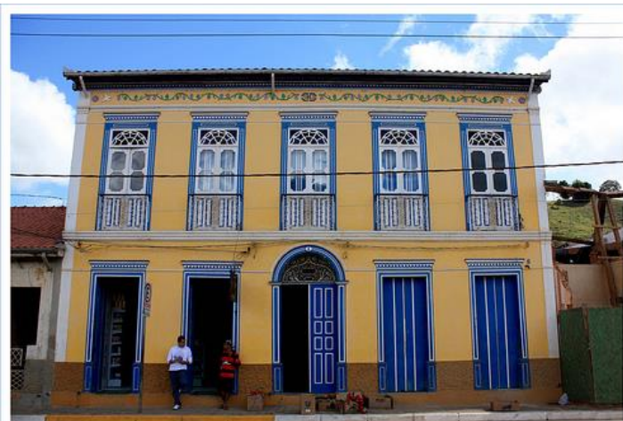
Fotografia 1 – Casarão colonial construído em 1853
