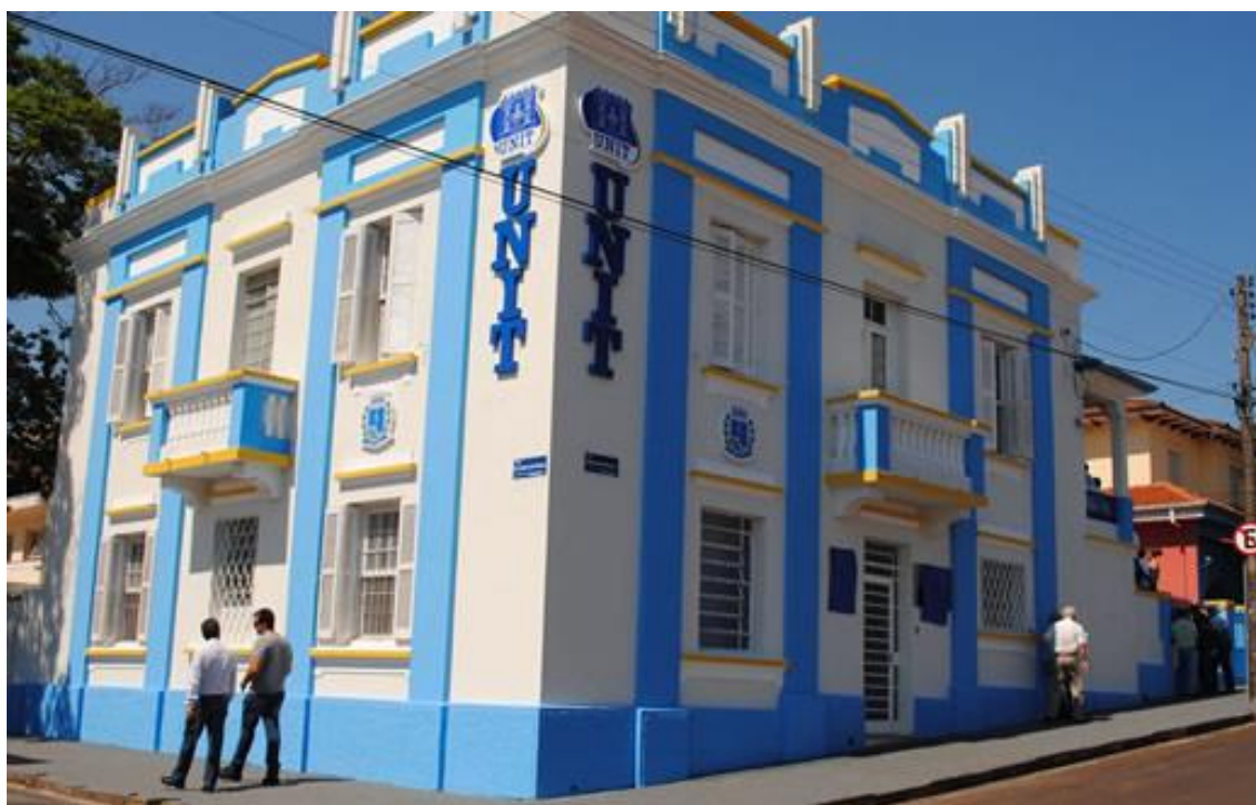
Figura 2 - Antigo prédio da Universidade do Trabalhador.
