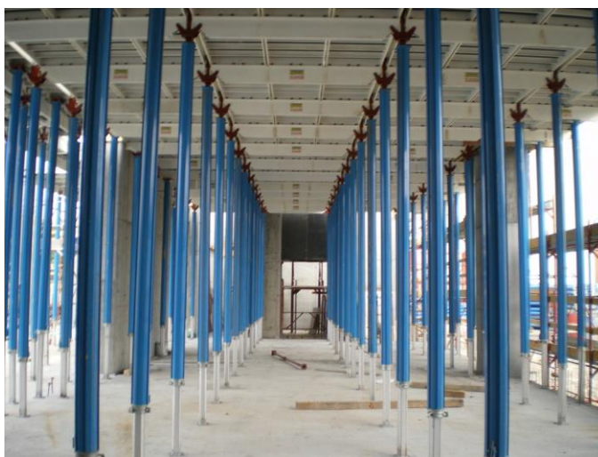
Figura 34: Utilização de escoras metálicas
