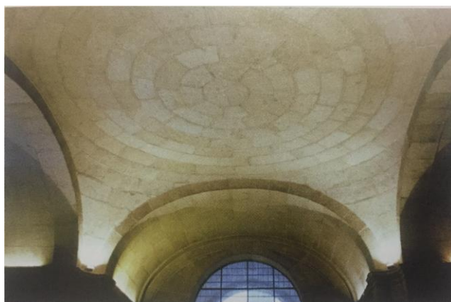
Figura 7: Abóbada abaulada cobrindo um vão de 8 metros de diâmetro
