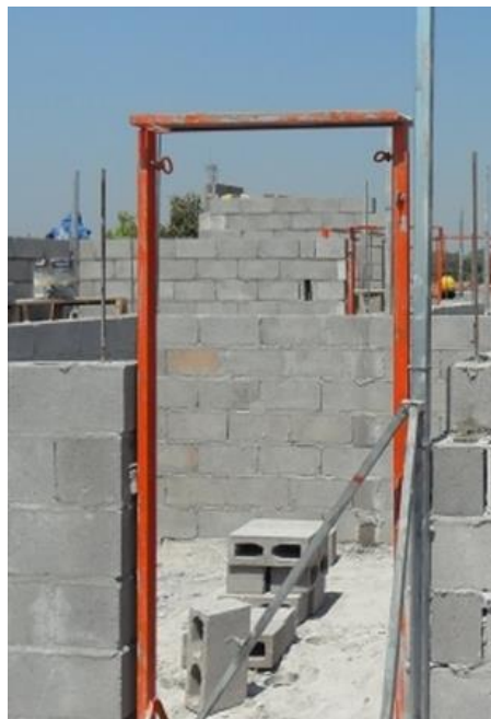
Figura 27: Gabarito de aço para portas
