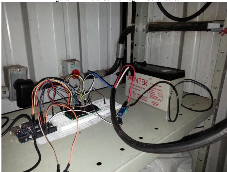
Figura 24 – Foto de montagem do circuito.
