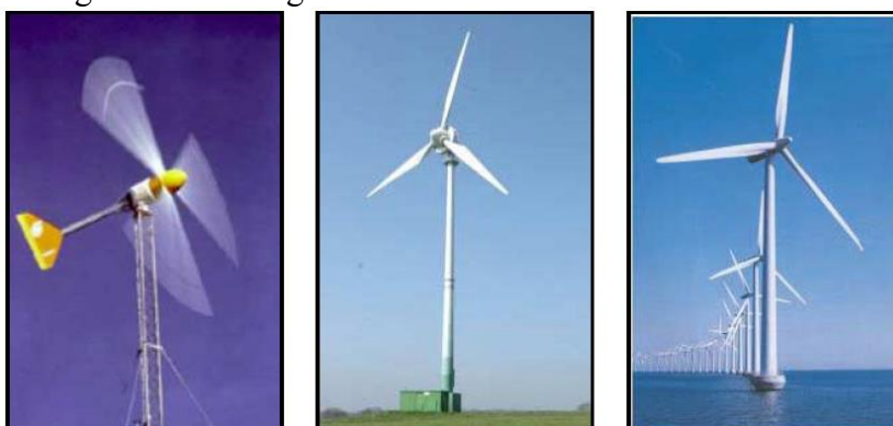
Figura 11 – Aerogeradores com rotores de eixo horizontal.
