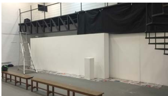
Figura 11: Saia cobrindo o vão sob o mezanino
