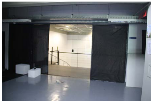
Figura 10: Colocação da primeira camada de tecido do black out na porta do segundo andar.
