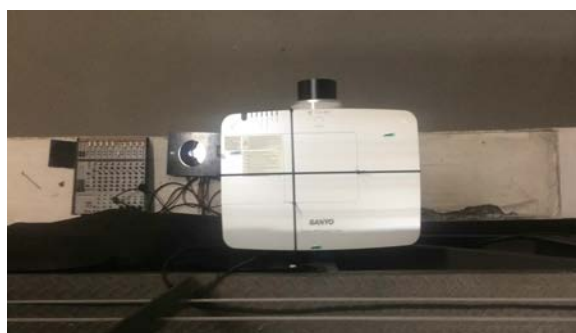
Figura 12: Parte do equipamento instalado sobre a parede.
