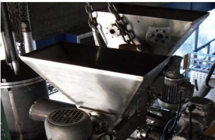
Figura 15 – Sistema de alimentação de biomassa
