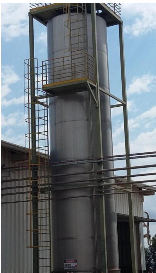
Figura 11 – Tanque de depósito de terebintina
