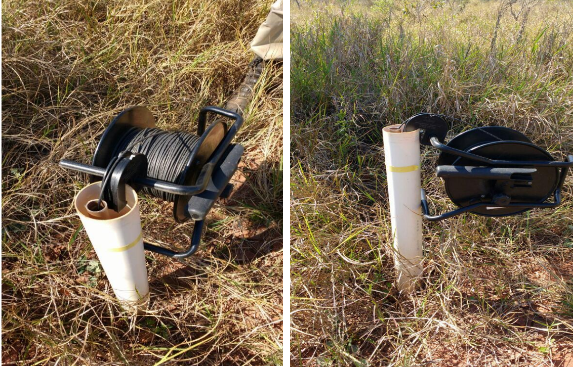
Figura 9 e 10: Medidor de Nível tipo carretel com sonda (SOL-10230); Medidor de nível instalado na parede externa do poço tubular.
