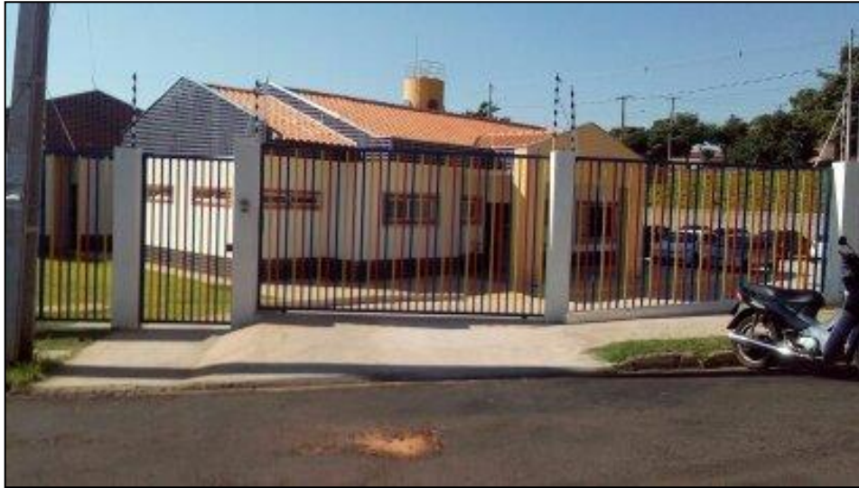
Figura 21 Creche já construída e em funcionamento.
