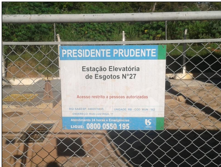
Figura 22 Estação de Tratamento de esgoto em funcionamento
