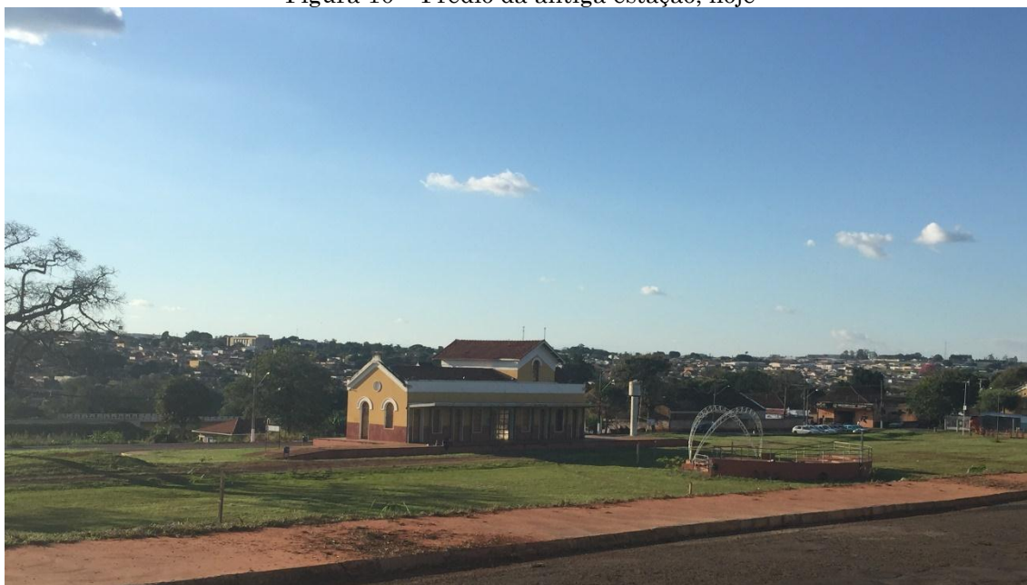
Figura 10 – Prédio da antiga estação, hoje
