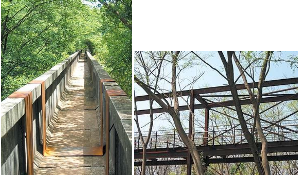
Figura 38 – Imagens das passarelas na muralha
