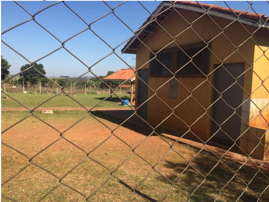
Figura 27 – Banheiros sem manutenção e sem funcionamento
