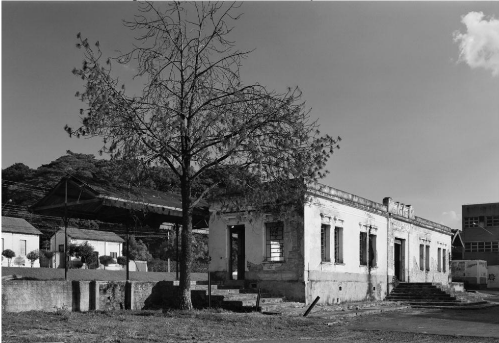
Figura 44 – Prédio sede da estação em 2004
