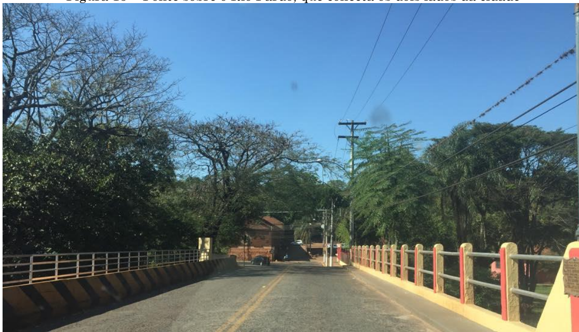
Figura 15 – Ponte sobre o Rio Pardo, que conecta os dois lados da cidade
