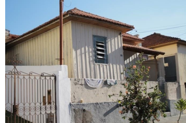
Imagem 07 – Residência de baixo padrão na Vila Liberdade
