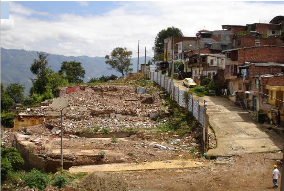
Imagem 39 – Área de implantação Biblioteca Parque Espanha – Antes da intervenção.
