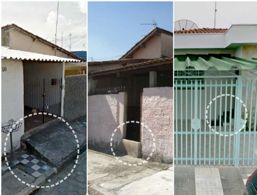
Figura 15 – Elementos presentes nas casas do entorno da área que indicam tentativas de conter a água da enchente.
