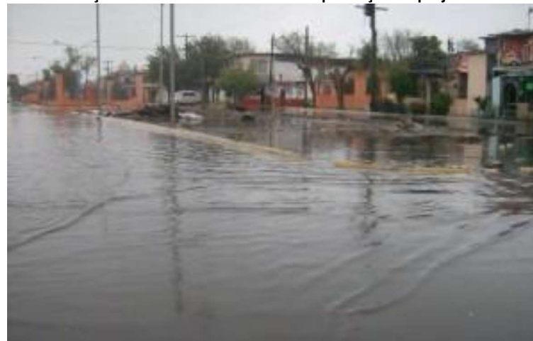
Figura 23 - Situação do Paseo Edison antes da implantação do projeto de drenagem.
