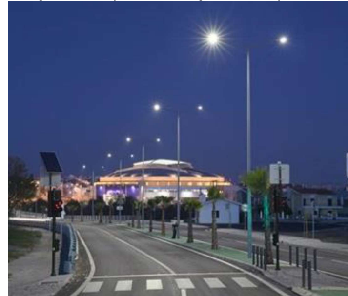
Figura 60 - Poste para vias de tráfego de veículos e pedestres.
