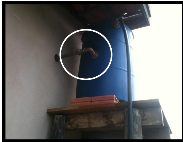
Figura 4.4 Tanque de controle de vazão.
