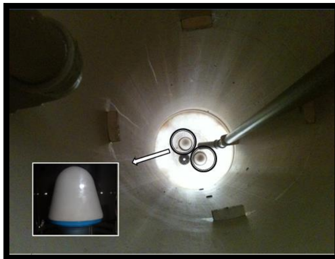
Figura 4.8 Local dos difusores de ar.
