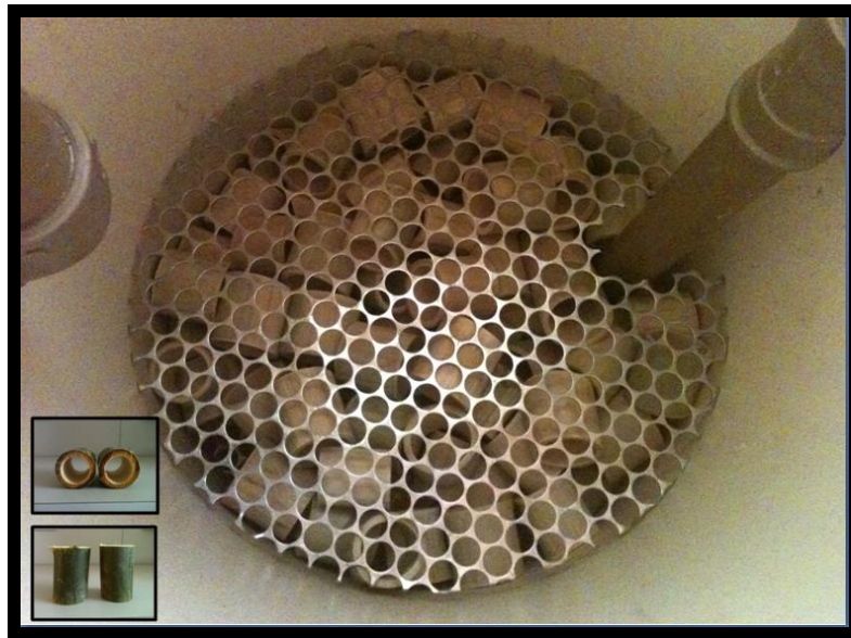
Figura 4.10 Anéis de bambu e suporte de metal que estão dentro da câmara aeróbia.
