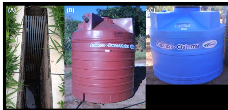
Figura 4.3 (A): Gradeamento; (B): Decantador primário e (C) Tanque de equalização.
