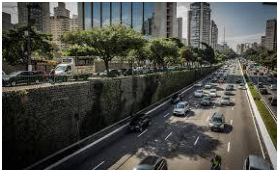
Figura 11: Resultado do corredor verde na Avenida 23 de Maio em São Paulo, SP
