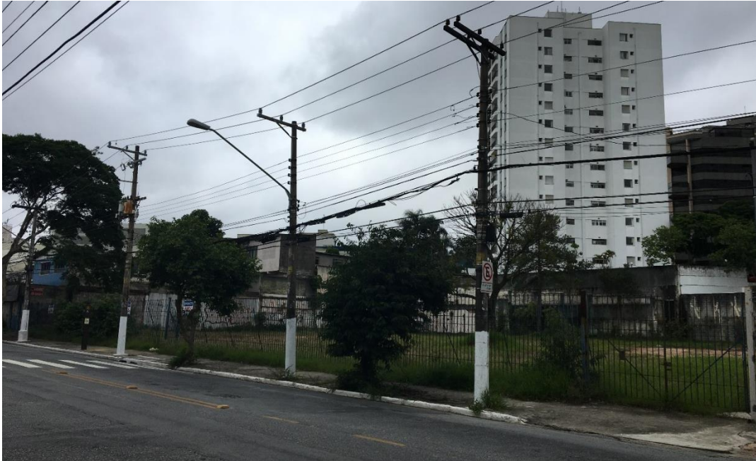
Figura 3: Imagem da fachada frontal do terreno
