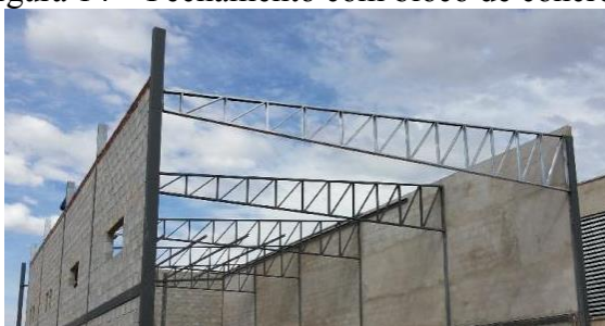
Figura 14 – Fechamento com bloco de concreto
