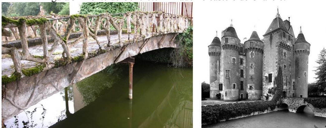
Figura 3 - Ponte de Concreto Armado no castelo de Chazelet
