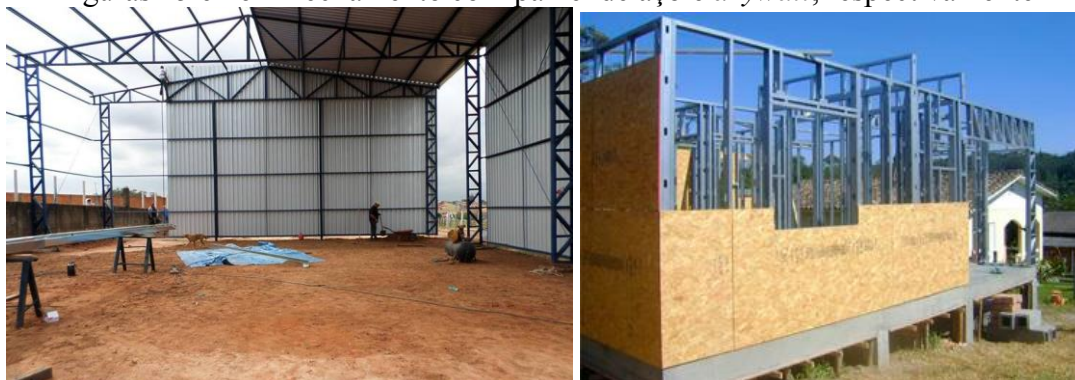
Figuras 15 e 16 – Fechamento com painel de aço e drywall , respectivamente
