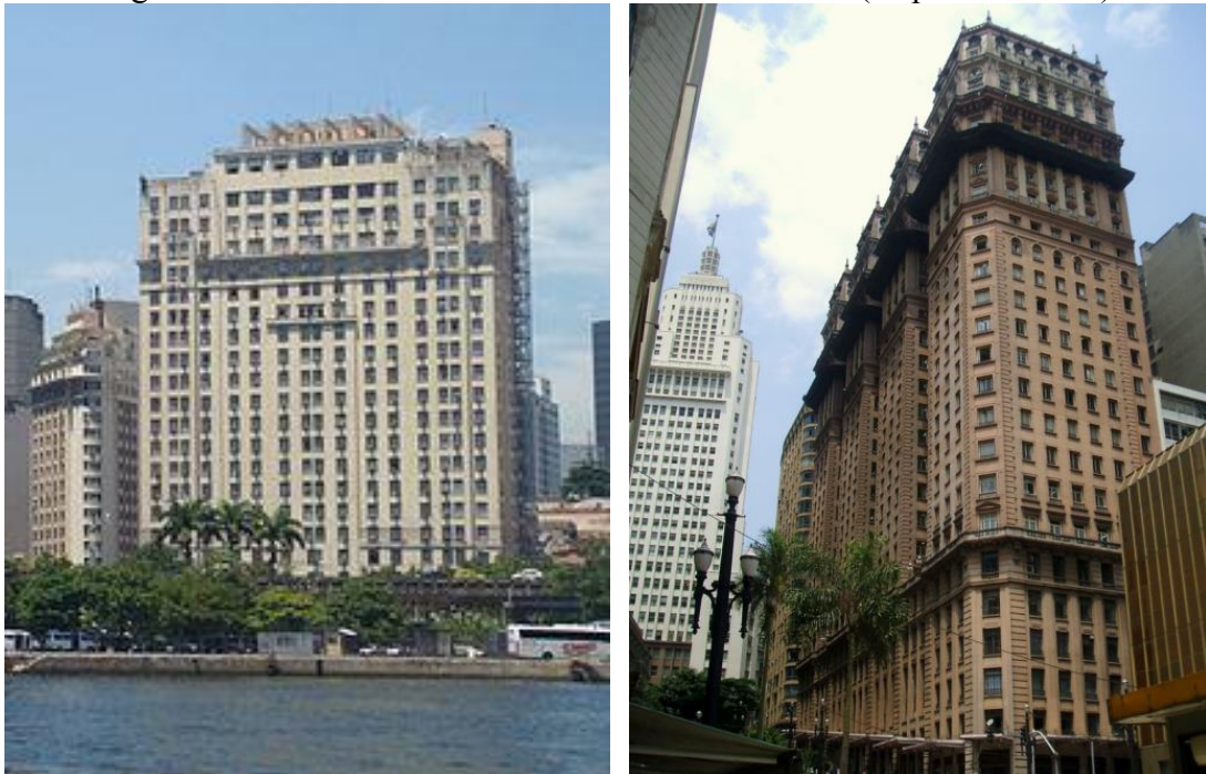
Figuras 6 e 7 - Edifício A Noite e Edifício Martinelli (respectivamente)
