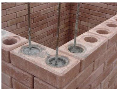
Figura 8 - Tijolos ecológicos preenchidos com concreto
