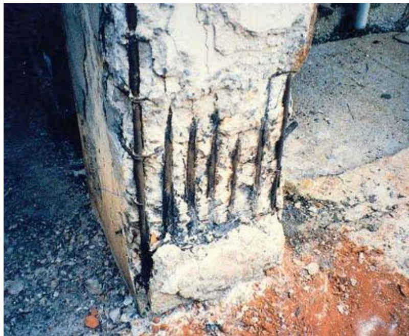
Figura 2 - Manifestação patológica em pilar de concreto armado.
