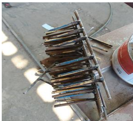
Figura 13 - Armaduras das vigas de aço CA-60.
