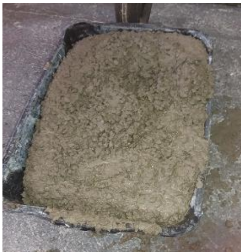
Figura 12 - Concreto utilizado para a concretagem.
