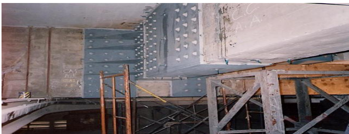
Figura 3 - Reforço por adição de chapas metálicas.
