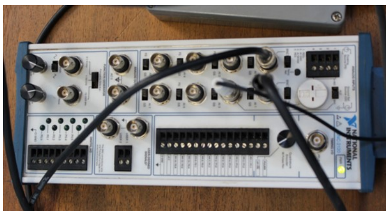
Figura 23 – Módulo de aquisição de dados, ao qual estavam conectados os sensores e a placa de aquisição de dados.
