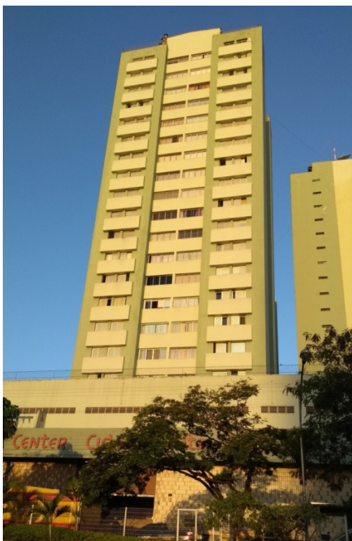
Figura 11: Condomínio vertical e Shopping Center em sua base no bairro Cidade Alta.
