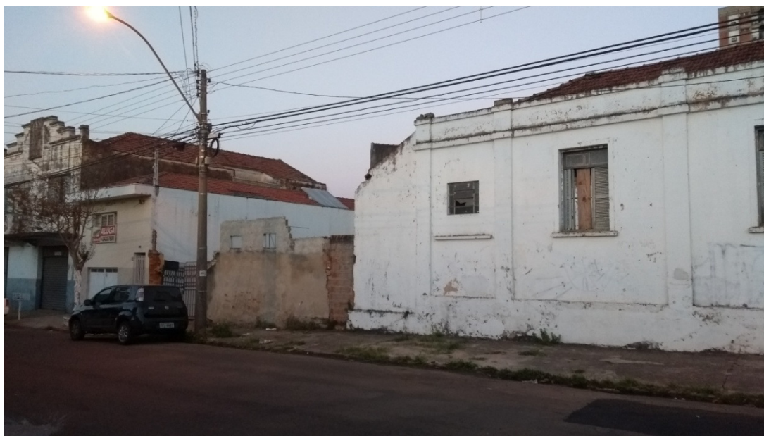
Figura 13: Construções abandonadas no bairro Cidade Alta.
