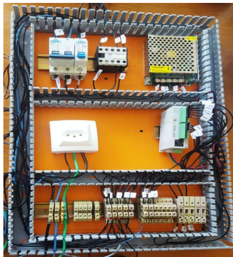
Figura 19 – Foto do painel elétrico em fase final.
