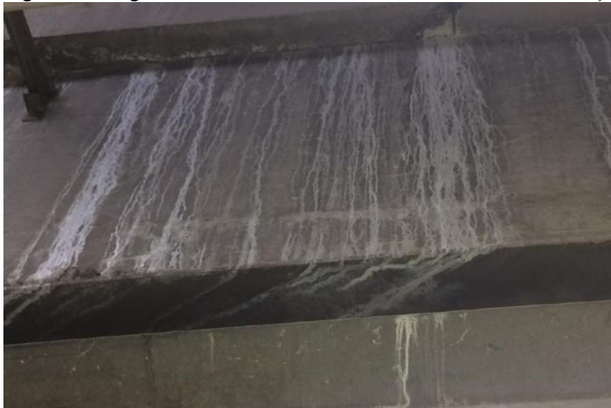
Figura 55 - Viga central - Manchas brancas indicando forte Lixiviação
