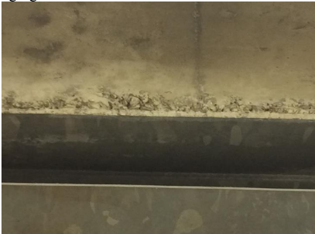
Figura 68- Viga Ambiente externo - Piso Flávio de Carvalho - Segregação nichos de agregados
