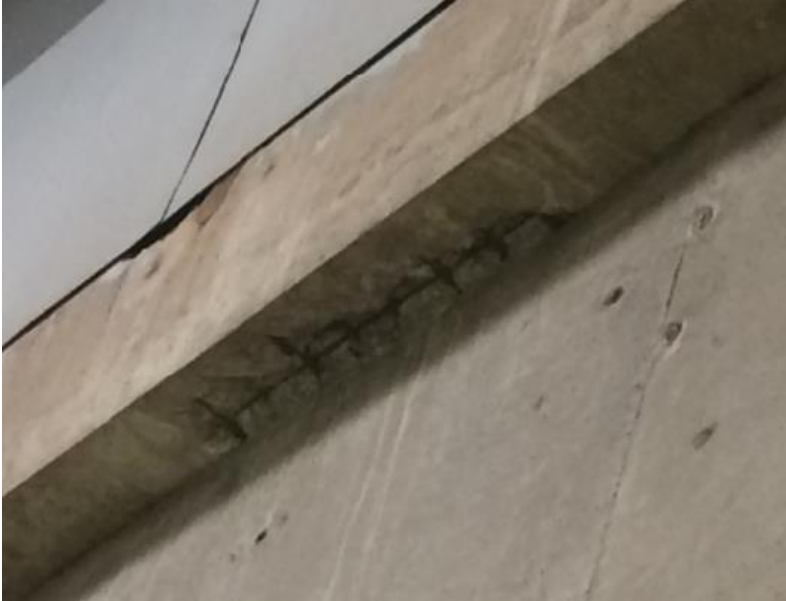
Figura 56 - Vigas centrais - Desagregação do concreto, possível carbonatação e corrosão da armadura
