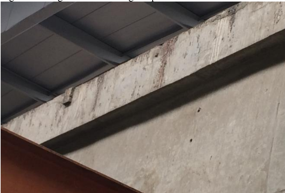
Figura 54 - Vigas centrais - Desgaste por abrasão
