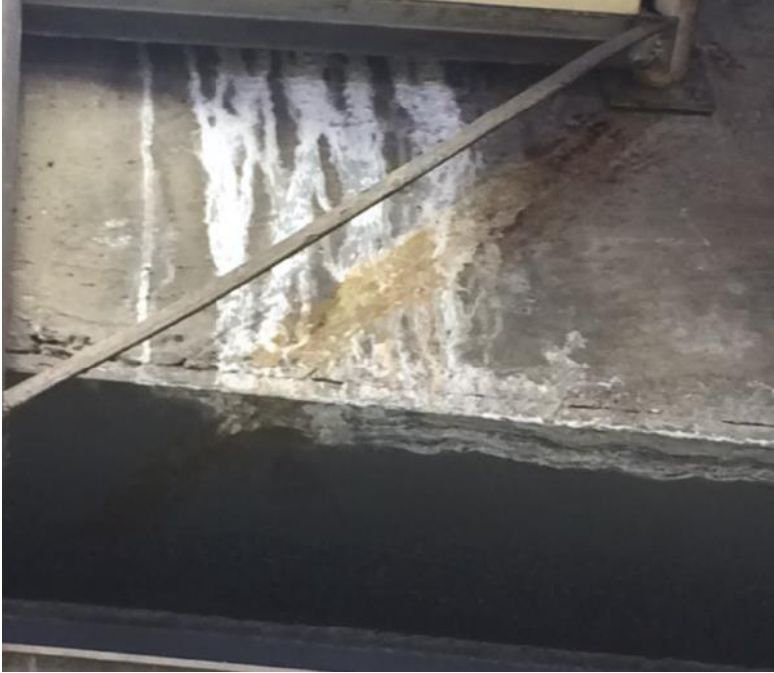
Figura 63 - Viga transversal piso Caio Graco - Forte lixiviação
