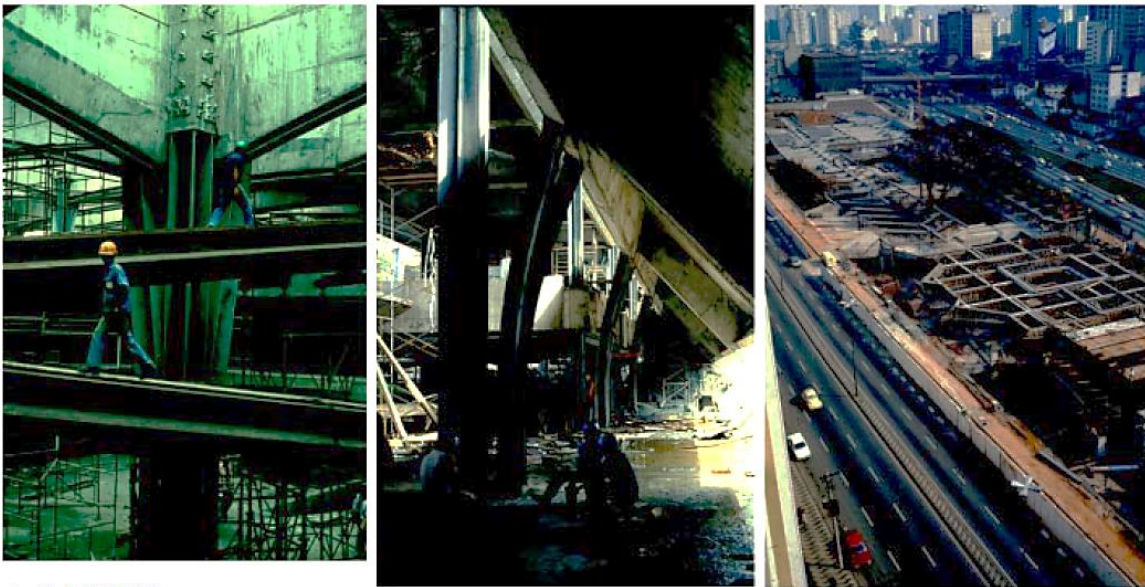
Figura 16 - Montagem das estruturas
