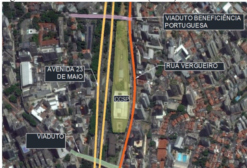
Figura 50 - Centro Cultural São Paulo (CCSP) - Vista aérea dos acessos
