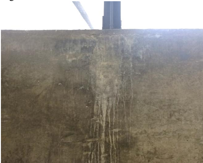
Figura 61 - Paredes externas - Piso Caio Graco – Lixiviação de intensidade média.
