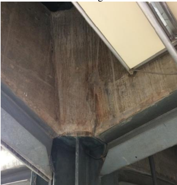
Figura 67 - Viga Ambiente externo - Piso Flávio de Carvalho - Lixiviação com manchas marrons indicando ferrugem
