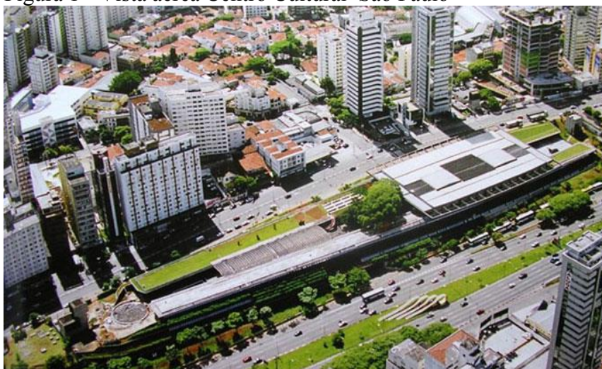
Figura 1 - Vista aérea Centro Cultural São Paulo
