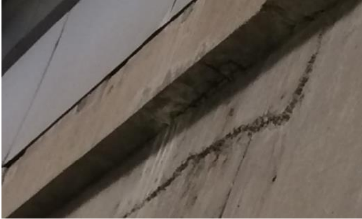
Figura 58 - Viga Central - Fissura horizontal e segregação do concreto
