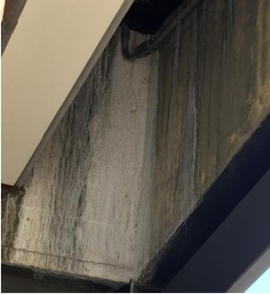
Figura 66 - Vigas - Ambiente externo - Piso Flávio de Carvalho - forte Lixiviação
