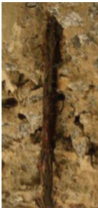
Figura 37 - Corrosão generalizada devido à carbonatação do concreto.
