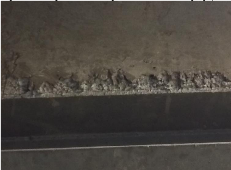
Figura 64 - Viga Transversal piso Caio Graco - Segregação com nichos de agregados
