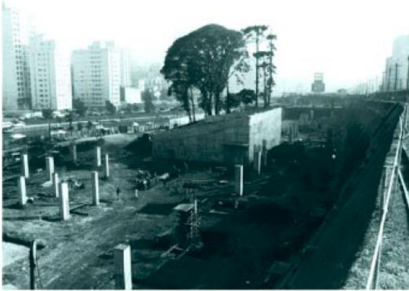
Figura 15 - Construção da fundação do CCSP
