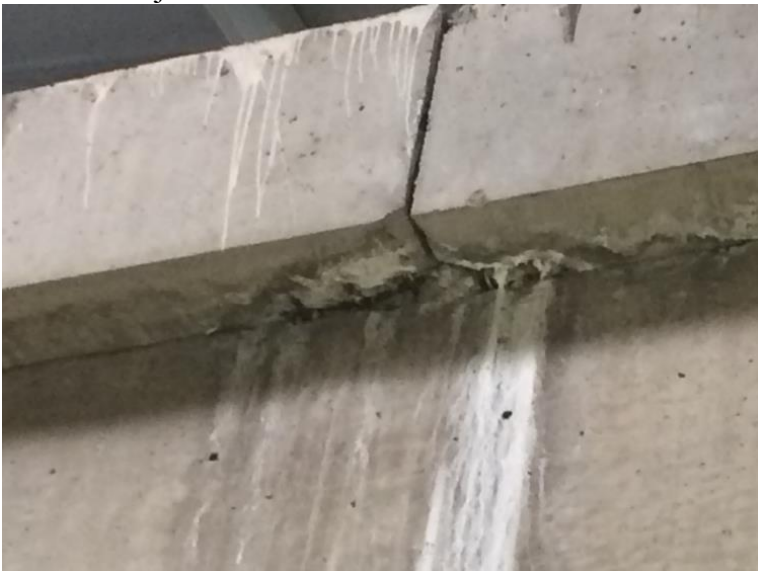
Figura 57 - Viga central - Apresenta lixiviação, corrosão da armadura, provável carbonatação e fissura na junta
