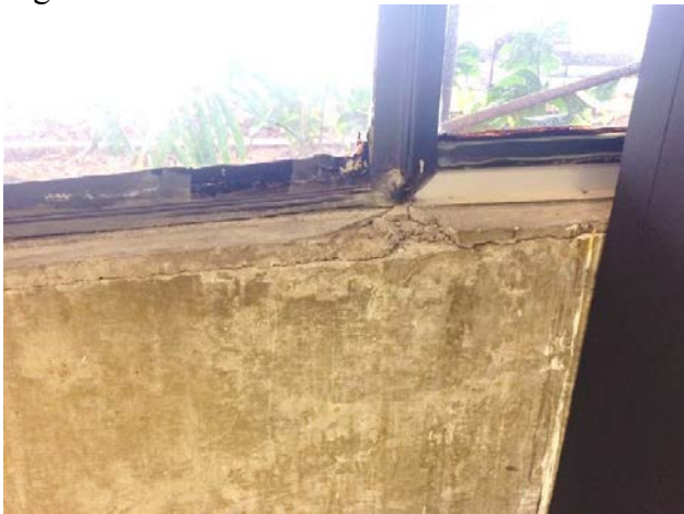
Figura 60 - Parede externas - Piso Caio Graco - Fissura horizontal e deslocamento.
