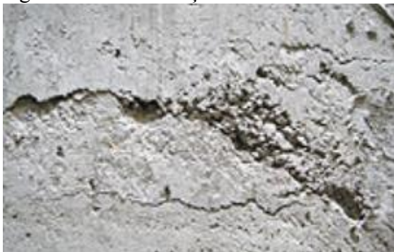
Figura 43 - Má vibração do concreto causando aumento porosidade do concreto
