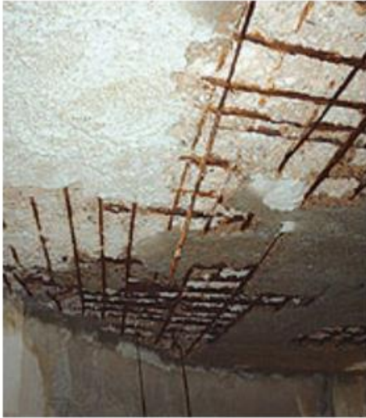
Figura 39 - Carbonatação de uma laje
