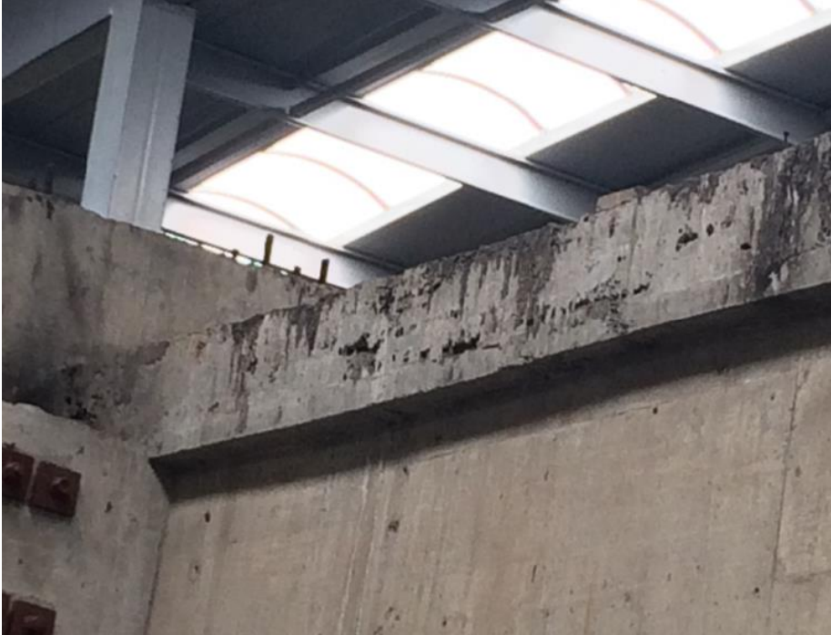
Figura 53 - Viga central - Manchas escuras
