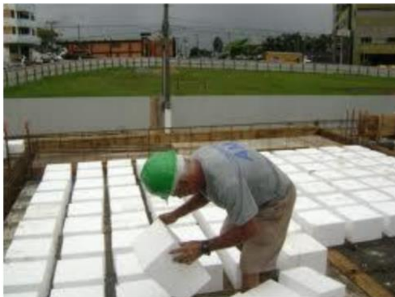
Figura 3: Laje preenchida com Isopor® diminuindo sem peso próprio.
