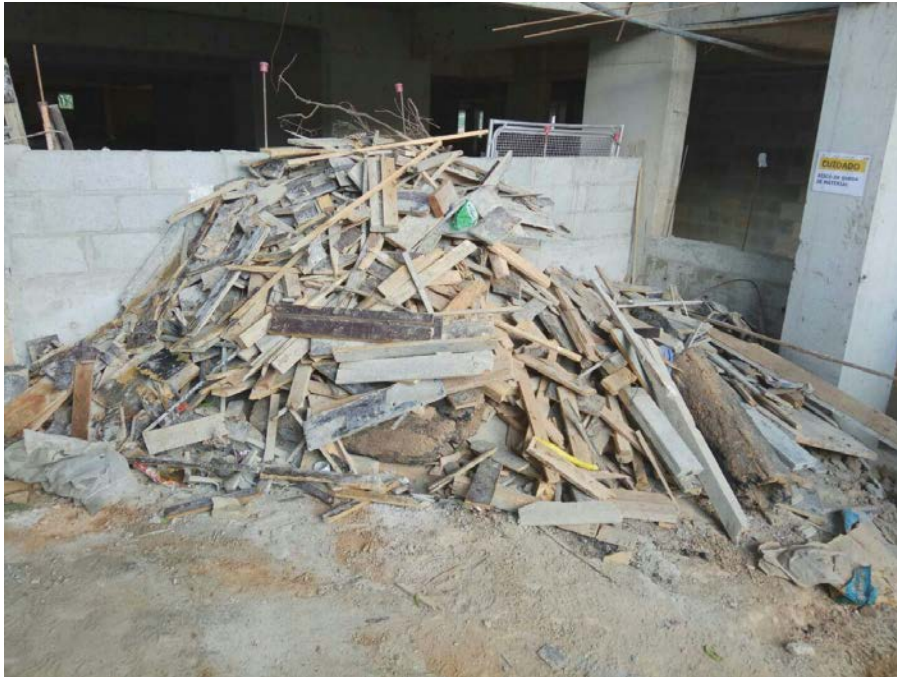
Figura 10: Geração de resíduos de madeira em obra (1)
