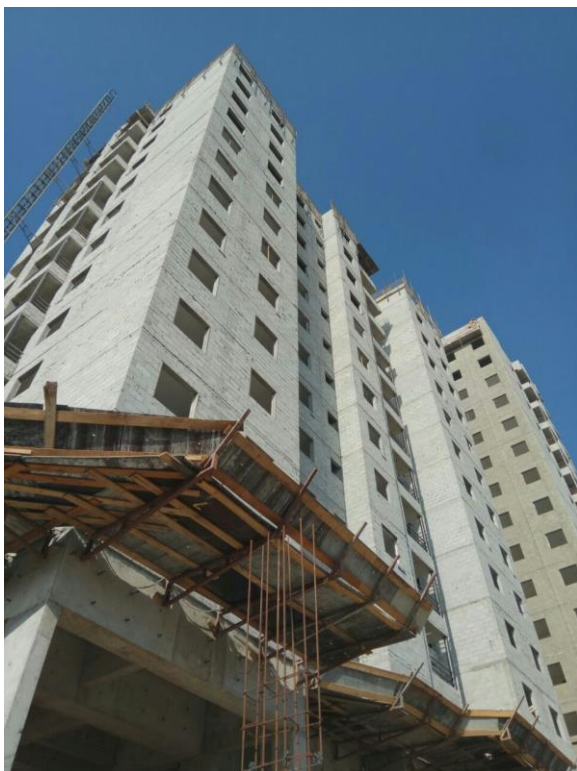
Figura 9: Detalhe de bandeja montada com sarrafo e madeirite plastificado
