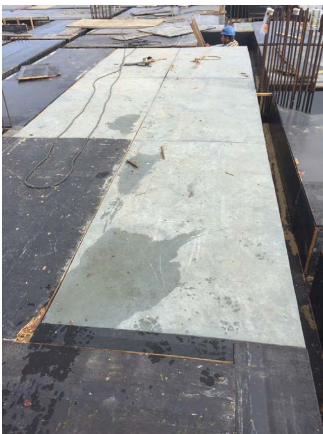
Figura 5: Exemplo de aplicação da chapa de madeira plástica em assoalho de laje
