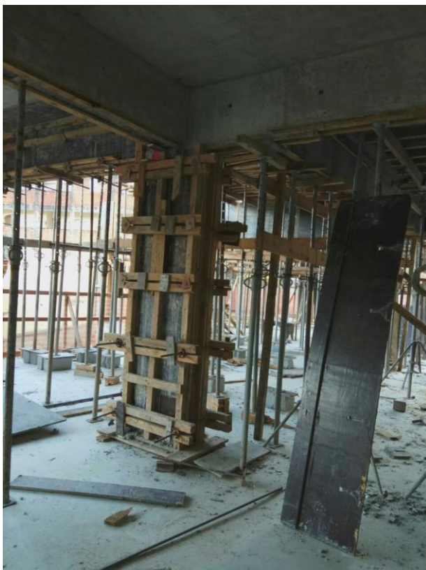
Figura 7: Detalhe de fôrma de pilar utilizando madeirite plastificado e pontalete
