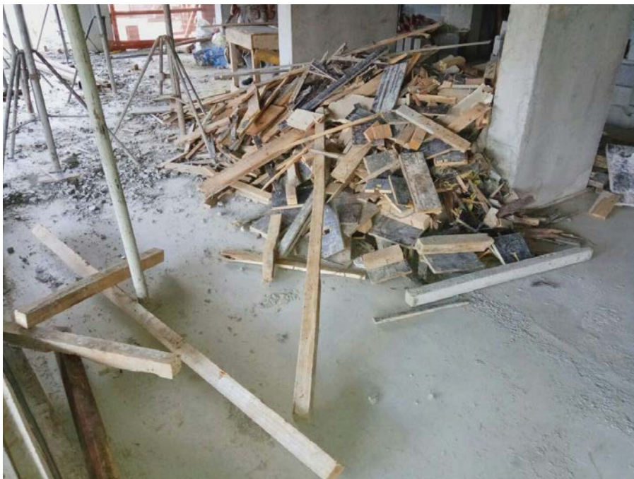
Figura 11: Geração de resíduos de madeira em obra (2)
