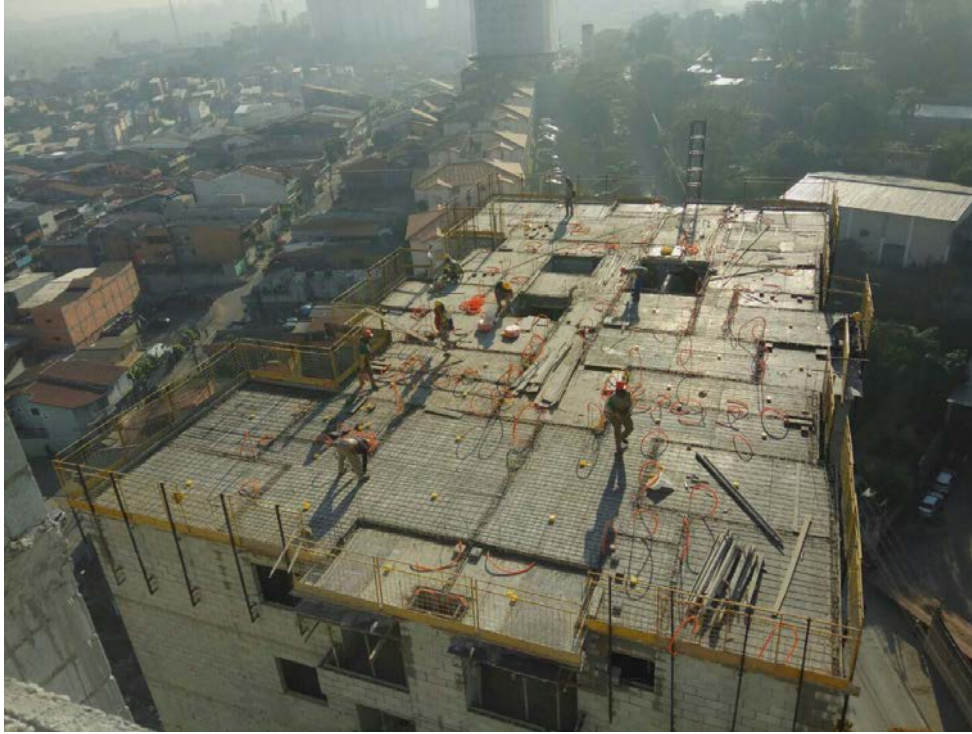
Figura 6: Detalhe de assoalho de pavimento tipo utilizando madeirite plastificado
