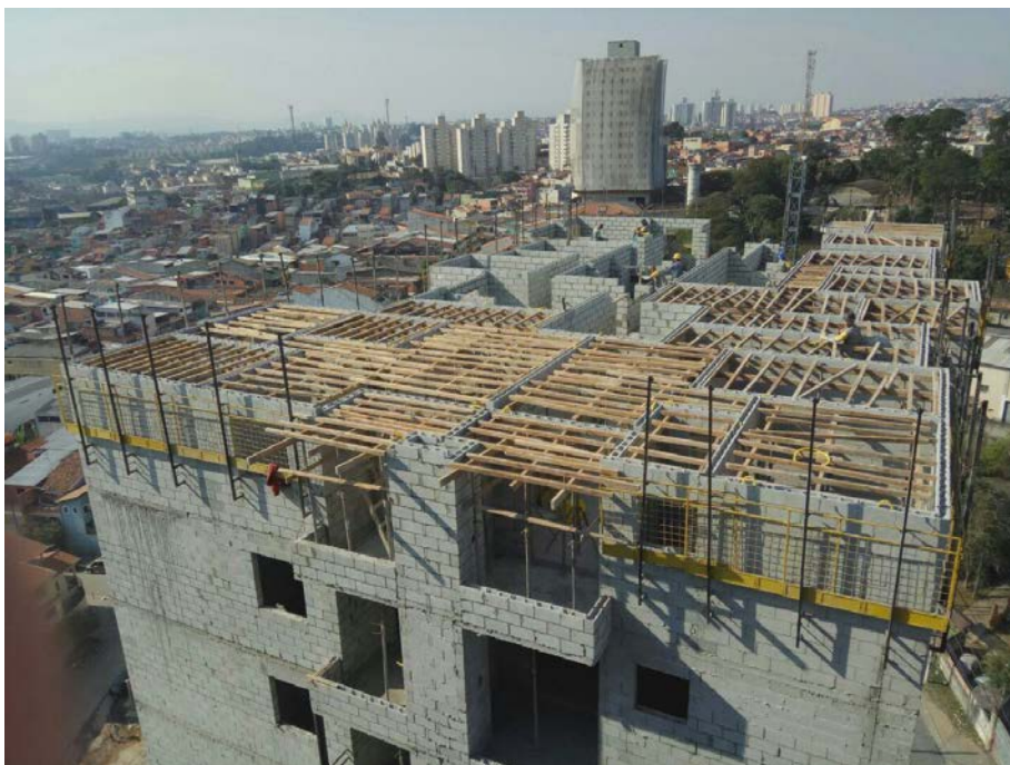
Figura 8: Detalhe dos pontaletes de apoio do assoalho da laje tipo
