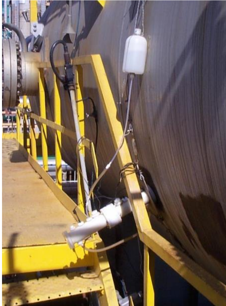
Figura 23 - Célula de hidrogênio de resposta lenta – acoplada externamente.
