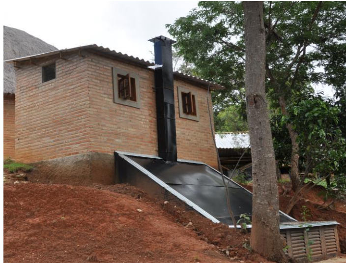
Figura 14. Banheiro seco com duas câmaras alternadas com rampa em Ravena/MG
