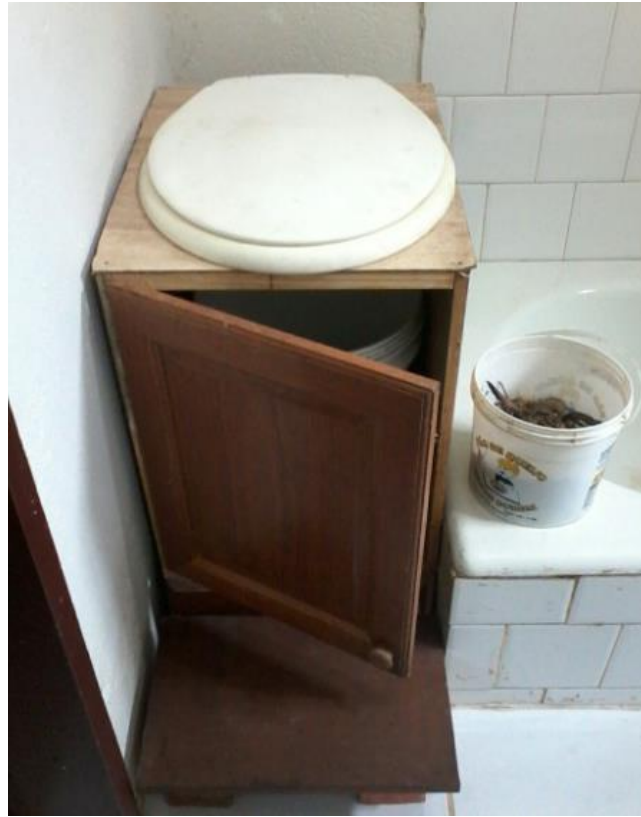
Figura 4. Banheiro simples de recipientes móveis em Araquari/SC
