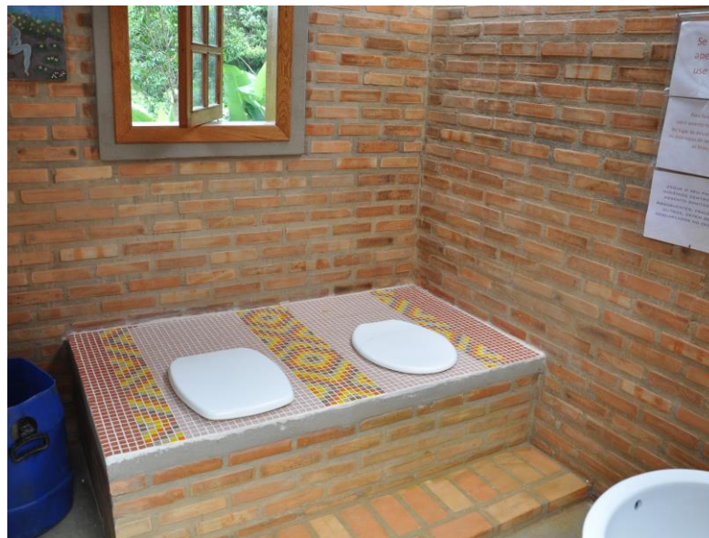
Figura 6. Interior do banheiro com duas câmaras, em Ravena/MG
