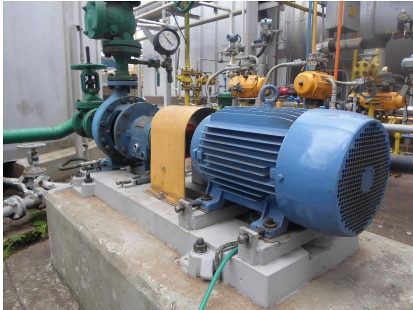
Figura 52 - Bomba centrífuga com acionamento por motor elétrico de indução
