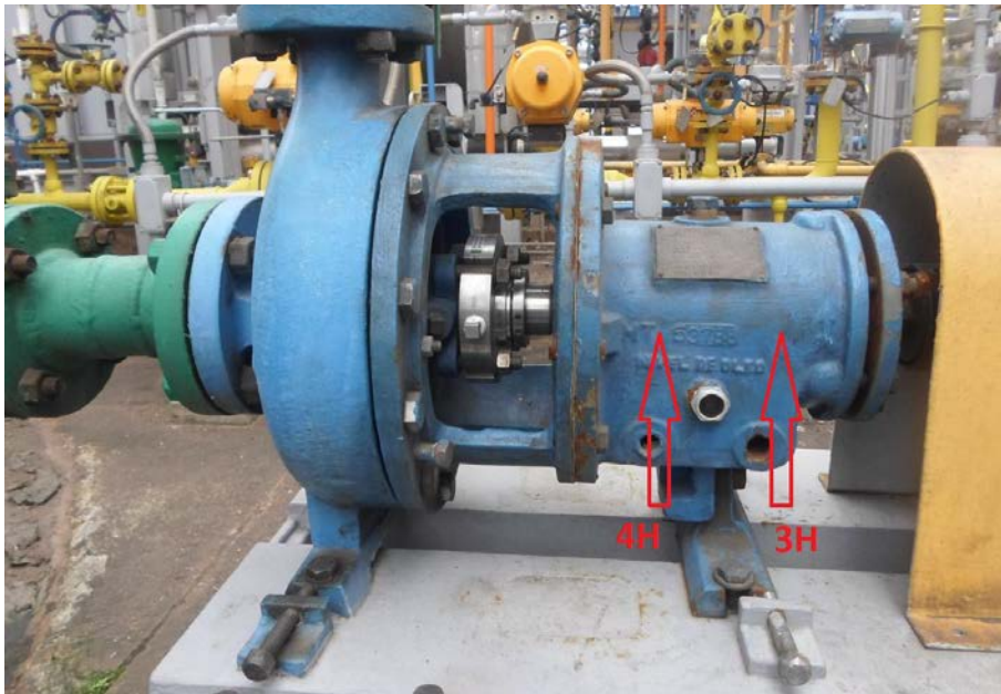
Figura 57 - Pontos de medição da bomba centrífuga, visão lateral
