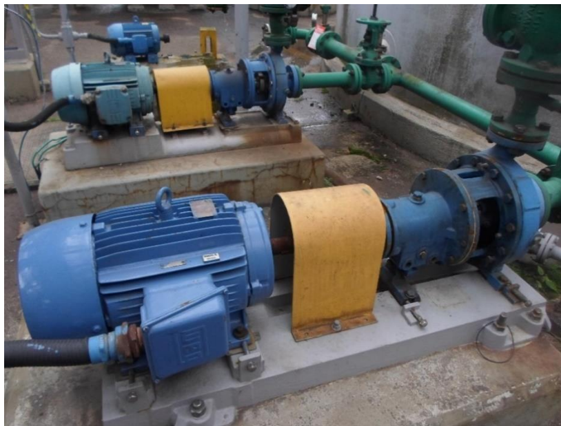
Figura 53 - Motor de indução e bomba centrífuga
