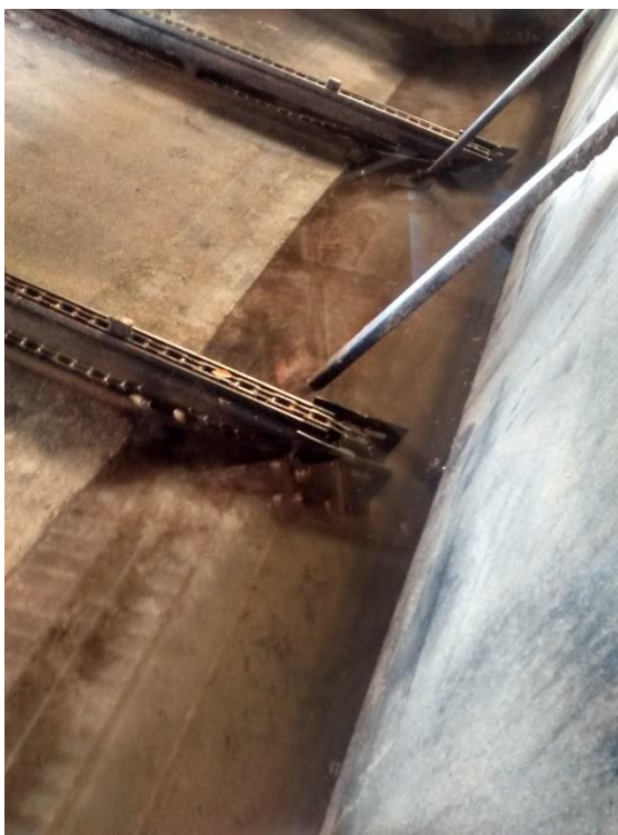
Figura 19 - Interior do tanque de imunização
