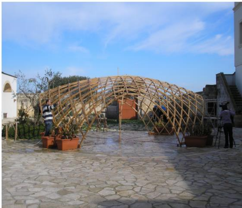
Figura 18 - Modelo da estrutura tracionada.
