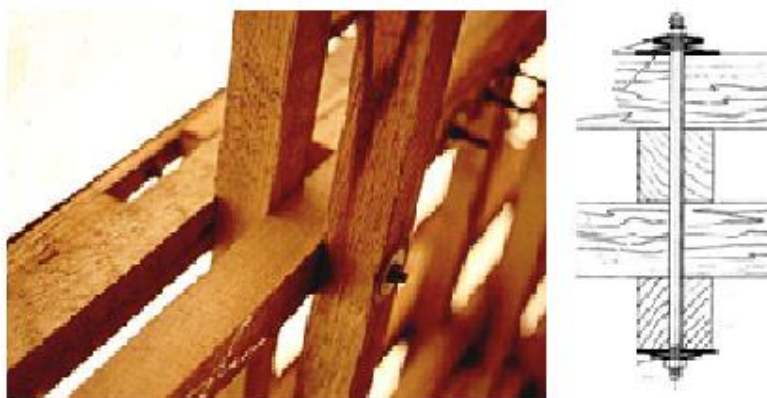
Figura 15 – Conexões do Gridshell Mannheim.
