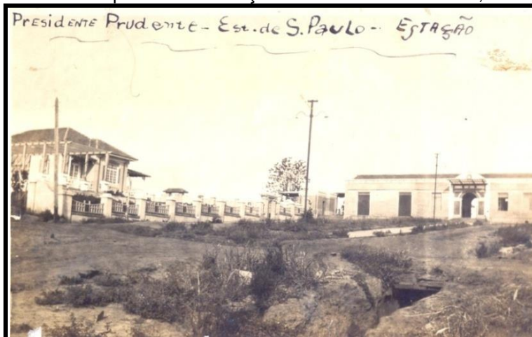
Foto 26: Esplanada da Estação Ferroviária Sorocabana, 1930
