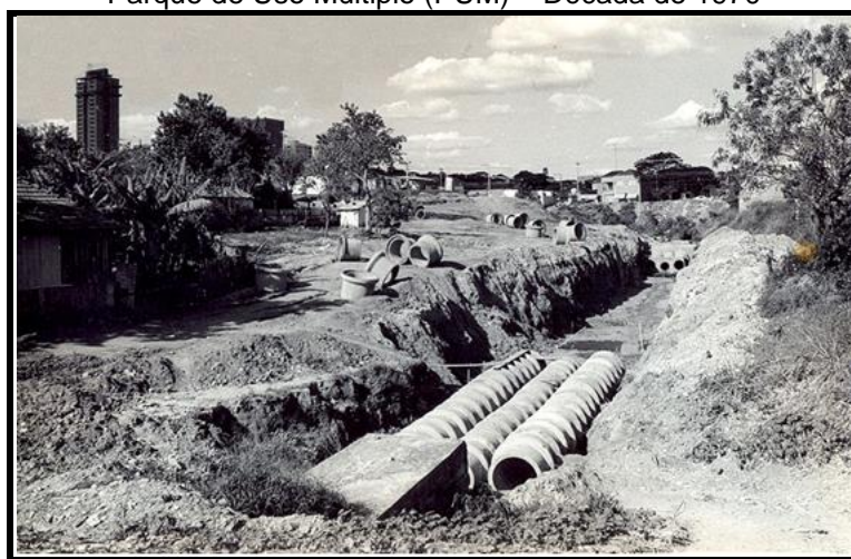
Foto 56: Canalização do Córrego Água do Bôscoli para a construção do Parque de Uso Múltiplo (PUM) – Década de 1970
