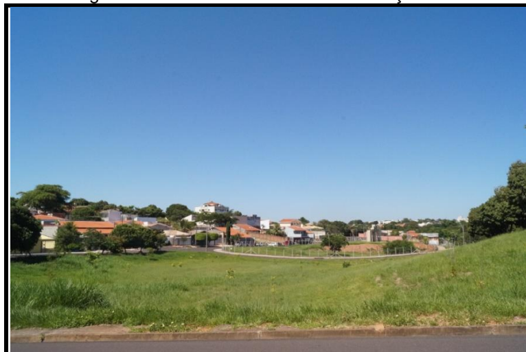
Foto 91: Trecho do afluente da margem esquerda do Córrego da Colônia Mineira – com canalização fechada
