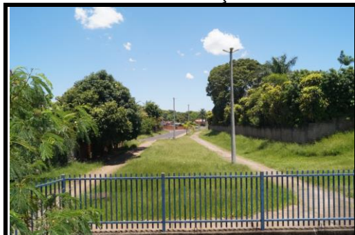
Foto 105: Córrego da Colônia Mineira Trecho I com canalização fechada
