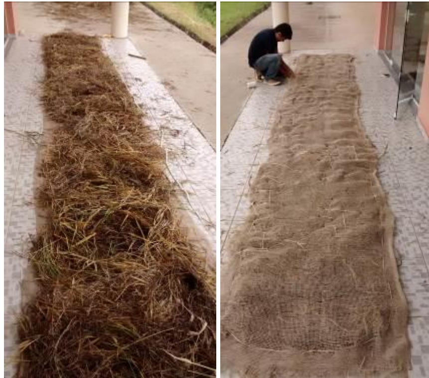
Figura 4.13 Foto da confecção das biomantas (esquerda) lançamento do capim seco, foto (direita) costura e fechamento da biomanta em forma de sanduiche.
