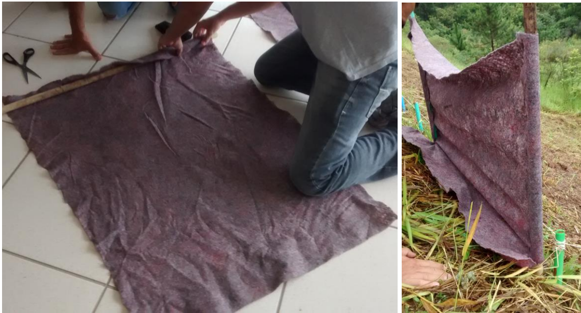
Figura 4.15 Confecção e ensaio de instalação de silt fence , detalhe da instalação onde parte do geotêxtil foi inserido no solo. Foto do autor (20/01/2017).
