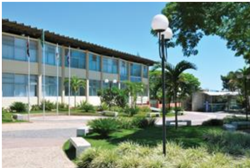
FOTO 4 – Prédio principal da unidade de Passos da UEMG
