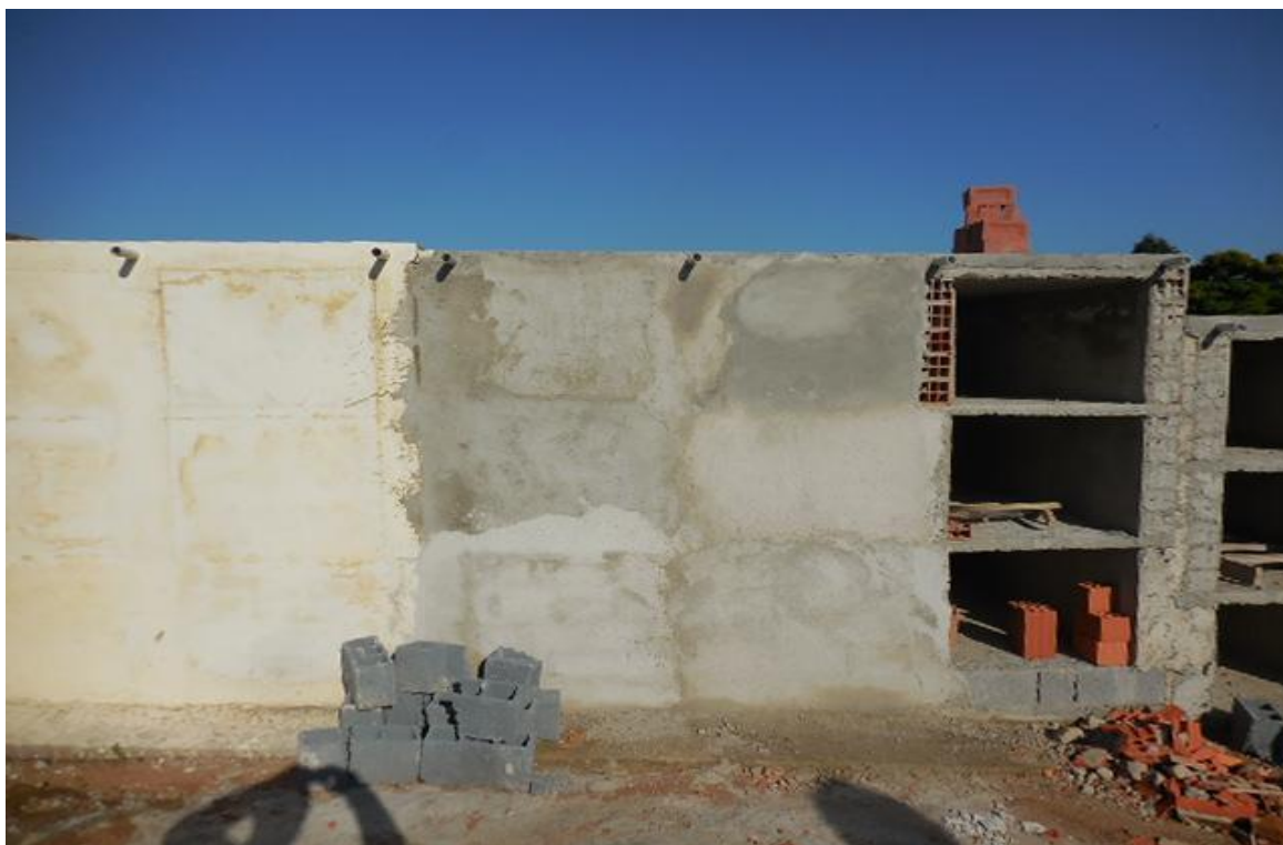
Figura 2 - Sepultamento vertical com disposição em gavetas, obra de ampliação sendo executada na Necrópole Jardim Eterno, Piedade, SP.
