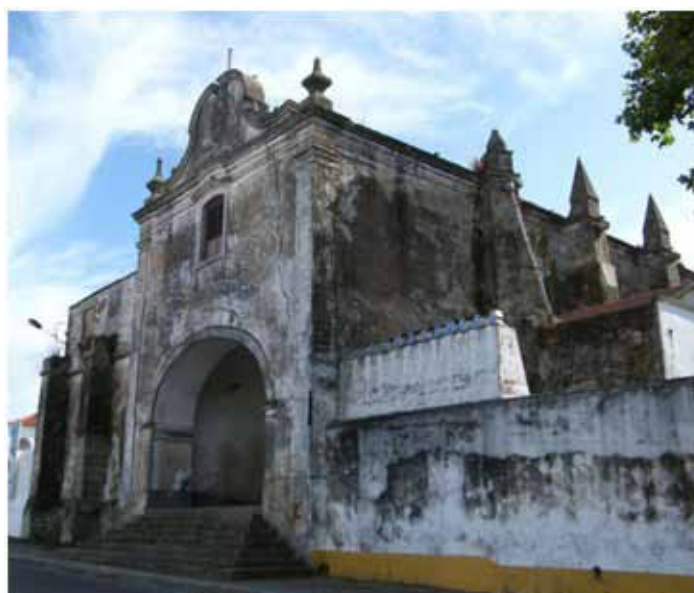
Figura 143 – Fachada principal da igreja do Convento de São Francisco. Montemor-o-Novo.
