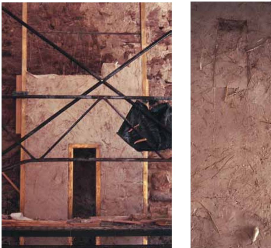
Figura 181 – Murmur. 2003. Processo de construção.
