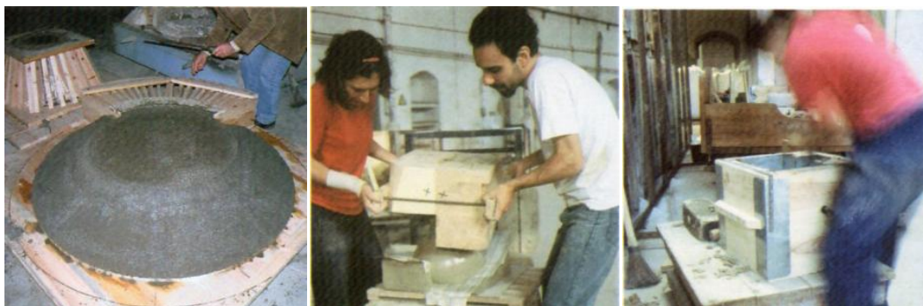
Descofragem – Fábrica de Refratários da Abrigada
