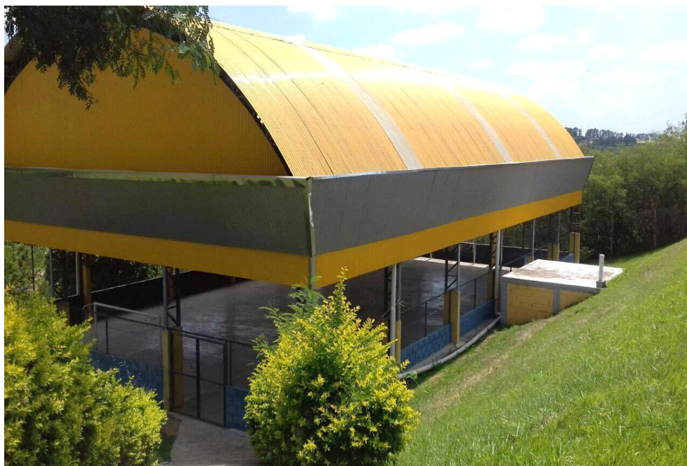
Figura 2 - Quadra das aulas de Educação Física da escola rural A
