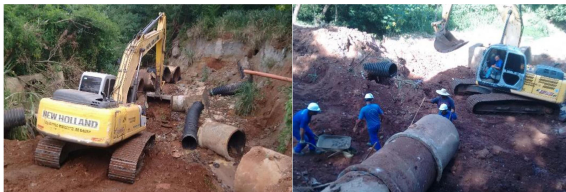
Figura 4.10 – Obras de recuperação da rede de galerias na microbacia Água Comprida ( http://www.bauru.sp.gov.br/materia.aspx?n=28914# ).
