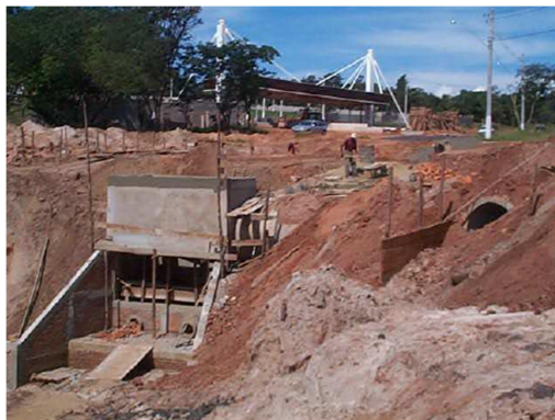
Figura 4.8 - Obra de contenção de erosão por dissipadores de energia. (CORGHI, 2008)
