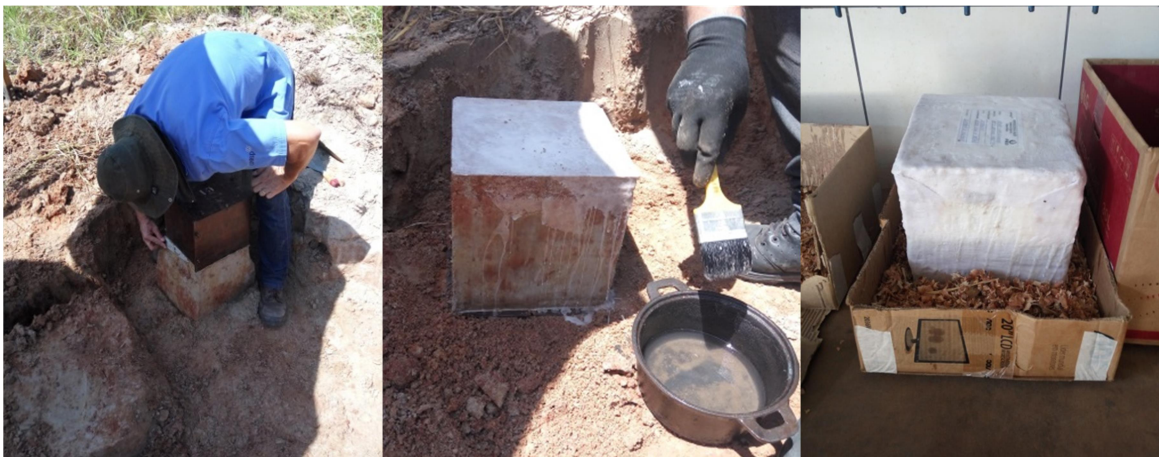
Figura 5.3 - Cravação da caixa metálica.
