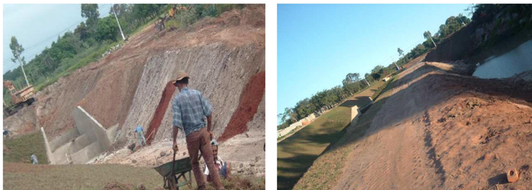
Figura 4.9 - Reparação do leito do córrego e instalação da rede de esgoto (CORGHI, 2008).
