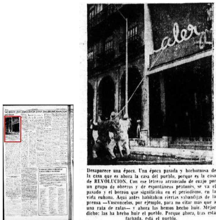
Figura 12 – Civis derrubando a fachada do jornal Alerta.
