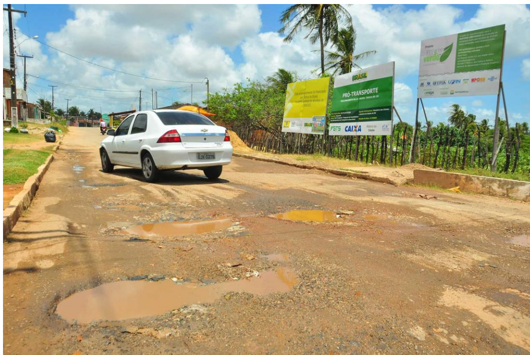
Foto 2: Prolongamento da Avenida Moema Tinoco da Cunha e as condições do asfalto nas imediações da sede da AMIGS. Fonte: Pesquisa de campo (Set. de 2014).
