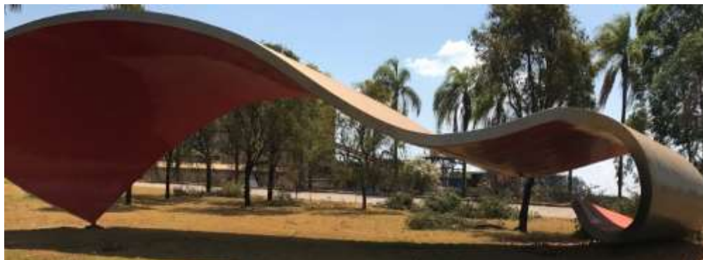
Figura 5 - Estrutura Curvilínea Fabricada com Uso de Nióbio.
