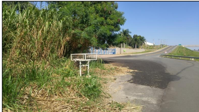
Figura 43: Trecho de APP do Ribeirão São João próximo a uma indústria
