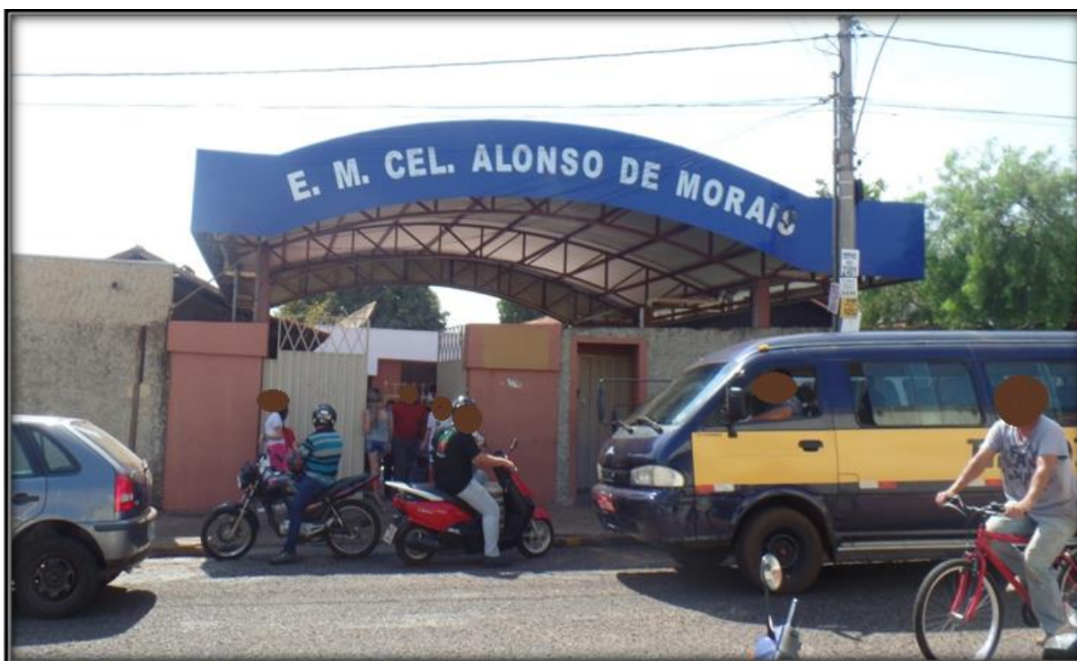
Figura 2 - Vista da fachada da Escola Coronel Alonso de Moraes
