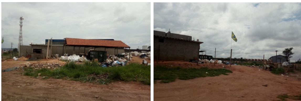
Figura 13 - Instalação atual da Associação Novo Tempo
