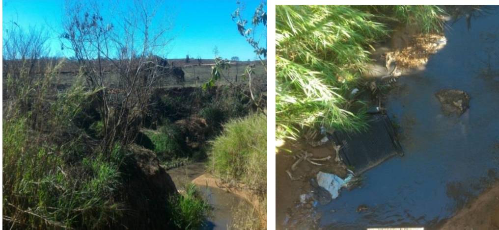
Figura 15- Lançamento do efluente tratado da estação de tratamento de esgoto (P3), município de Dracena - SP, 2017
