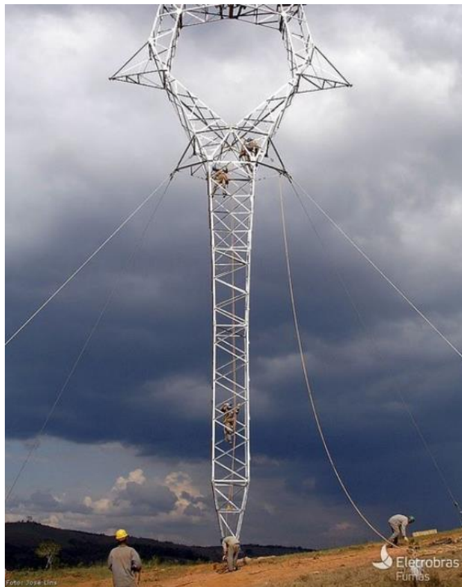
Figura 11 – Torre metálica treliçada do tipo estaiada.
