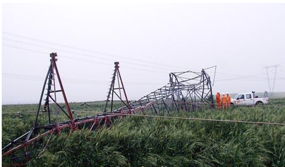
Figura 23 – Torre caída na projeção horizontal sob análise dos técnicos da COPEL
