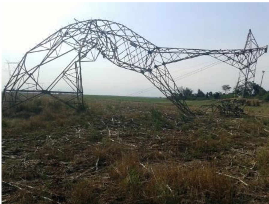
Figura 22 – Torre retorcida e deformada em Santa Helena de Goiás.
