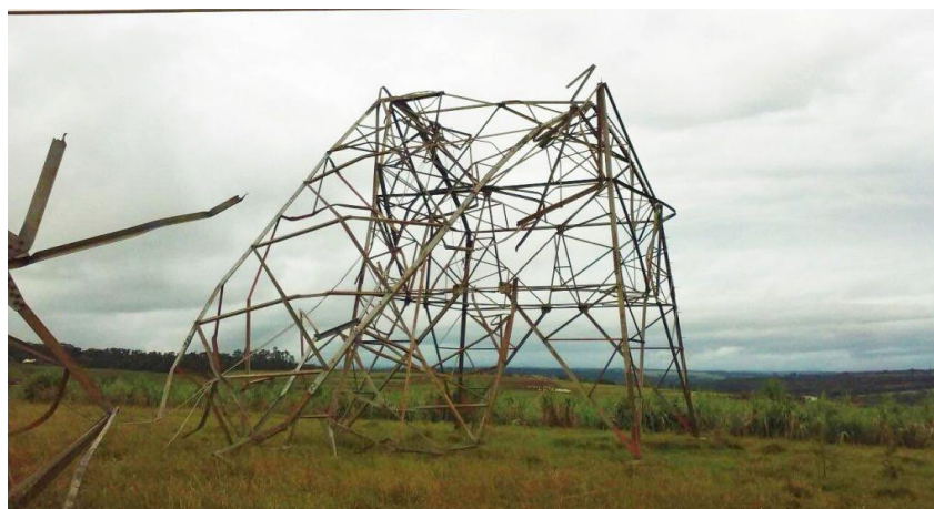
Figura 20 – Torres retorcidas e deformadas após a chuva e consequências.
