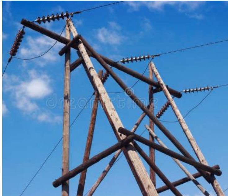
Figura 13 – Torre treliçada de madeira tipo autoportante.
