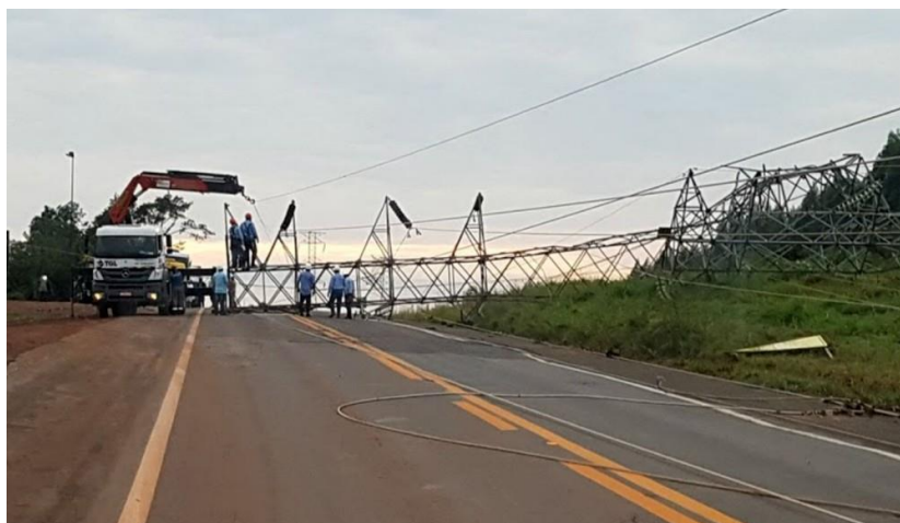
Figura 21 – Estruturas caídas sobre a BR-262.
