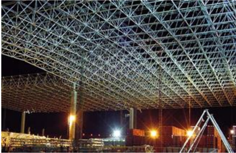
Figura 27 – Galpão executado com treliça espacial.
