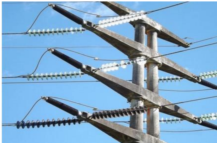
Figura 14 – Torre de concreto armado tipo autoportante.
