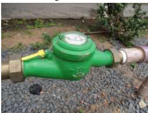
Foto 5 – Vista geral do hidrômetro
