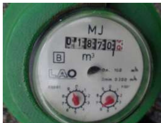
Foto 6 – Detalhe do hidrômetro
