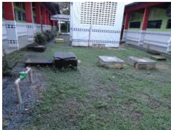
Foto 4 – Acesso à cisterna
