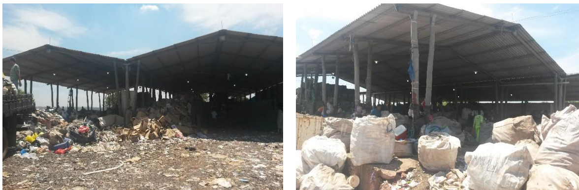
Figura 15: Vista externa do galpão da Cooperativa Reciclador Solidário (Piracicaba/SP) – 2017.
