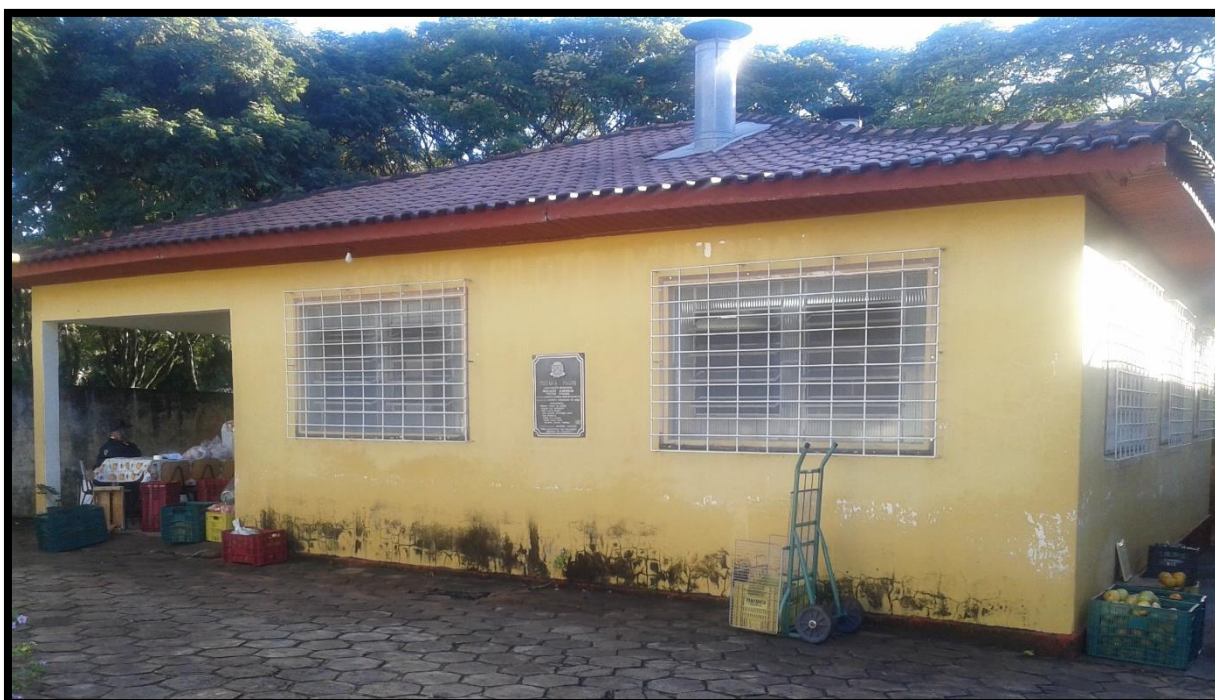
Figura 2: Edificação da Cozinha Piloto no município de Regente Feijó. Fonte: Pesquisa de campo, fevereiro de 2017.
