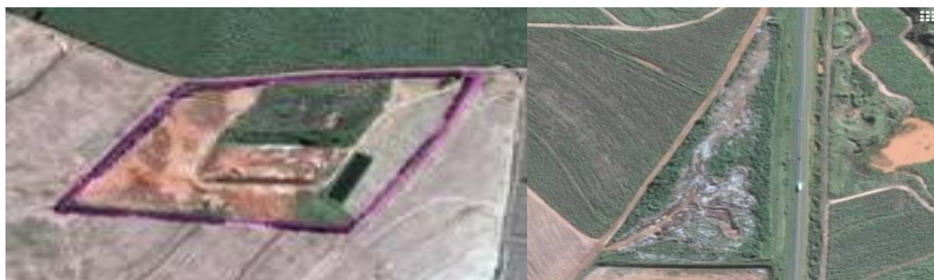
Figura 19 - Aterro sanitário e de Inertes
