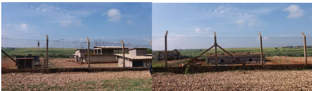
Figura 18 - Estação de Tratamento de Esgoto do município de Barra Bonita/SP
